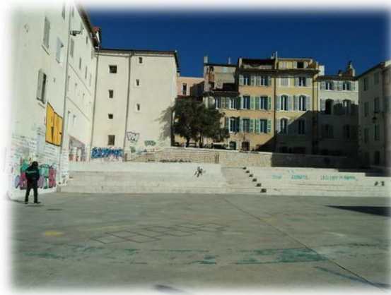
Figure IV.37: La dalle en béton, 2018
