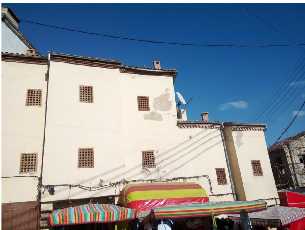
**Figure 4-12 : Image de la maison 19-19 bis montrant le détachement des enduits extérieurs après les travaux**
