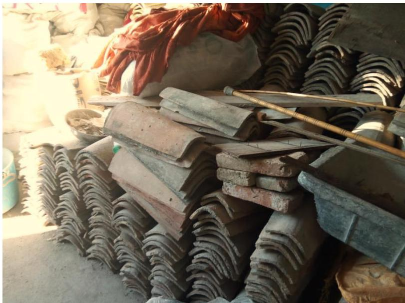
**Figure 7-18 : Les tuiles anciennes récupérées et utilisées pour la réfection de la toiture dans le Cas N2**
