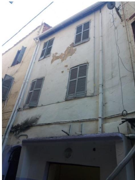
**Figure 7-20 : La façade de la maison réhabilitée sans autorisation (Cas N6) sans aucune trace de travaux consistants, à part les canalisations des eaux pluviales**
