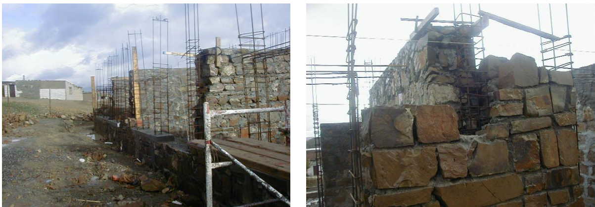
Figure 7.4. Logements à usage d'habitation en pierre de ramassage réalisés avec le système constructif à base de maçonnerie porteuse chaînée (Médéa, Sud-Est d'Alger, 2007)
