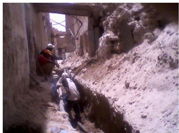
Figure 6.7. Travaux de viabilisation à l'intérieur du ksar de Ouargla, 1970.
