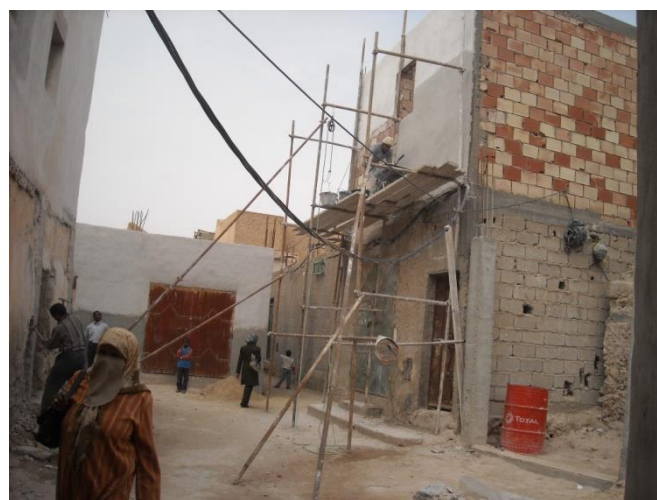
Figure 6.36. Reconstruction de maison à l'intérieur du ksar de Ouargla avec du béton.
