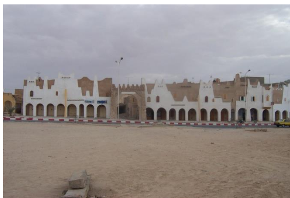
Figure 6.10. Réhabilitation de la façade Sud-Ouest du ksar de Mestaoua.
