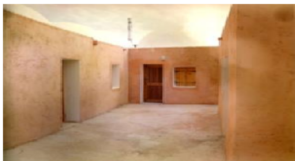
Figure 6.13. Maison témoin réhabilitée au ksar de Témacine.
