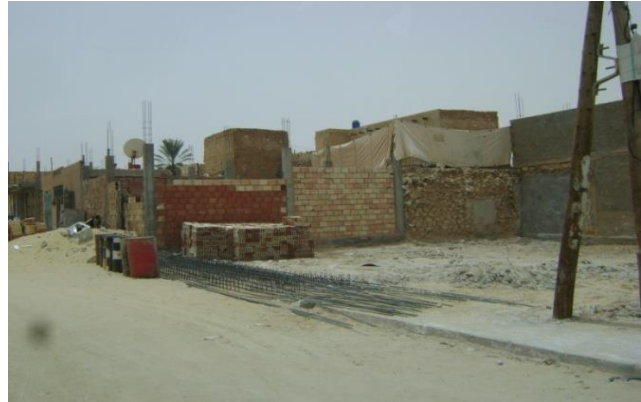
Figure 6.37. Reconstruction de maison à l'intérieur du ksar de Mestaoua avec du béton. Source : DUC Ouargla, 2015.
