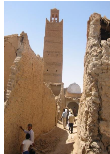
Figure 6.11. Intervention sur le ksar de Témacine.
