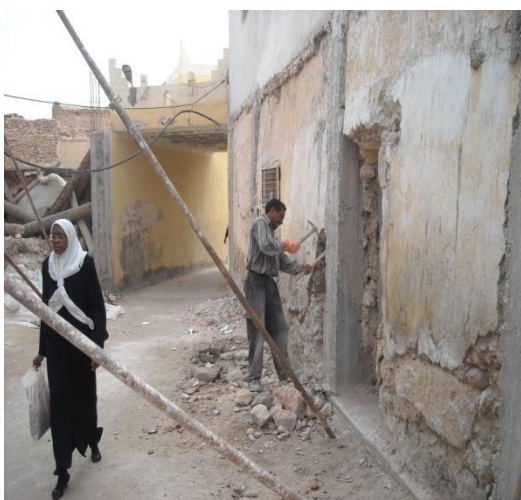
Figure 6.35. Rénovation d'une maison au ksar de Ouargla avec du béton.
