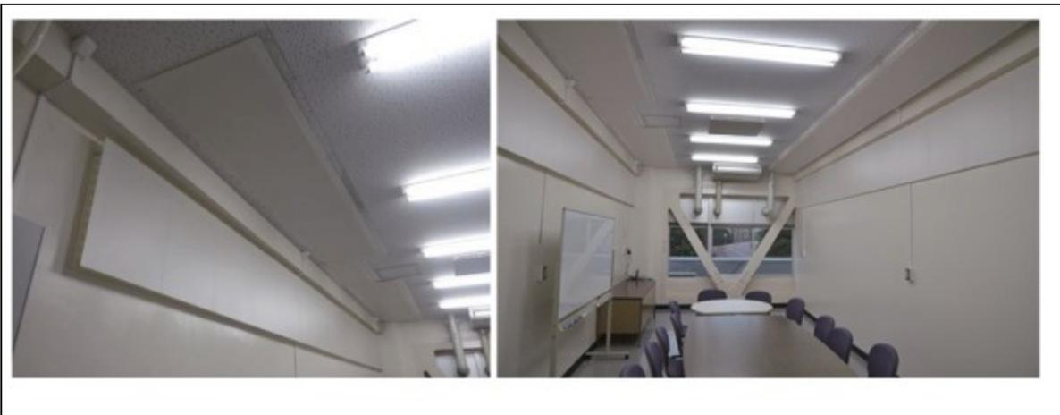
**Figure 4.23:** Installation et disposition d'absorbeurs MPP à nid d'abeille. Source: Hoshi K et al. (2019)
