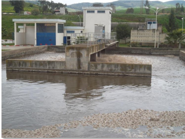
Figure III.7. Foisonnement dans les bassins biologiques ( STEP IBN ZIAD, Constantine )
