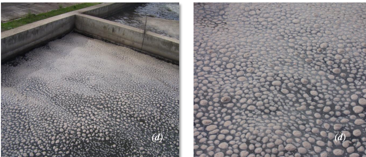
Figure I.9. Photos des bassins biologiques dans la station d'IBN ZIAD Constantine, présentant des états de foisonnement de boues.
