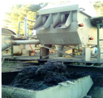
Figure 8. Récupération des boues (Photo prise de la tannerie DMD s.p.a. Solofra, Italie)
