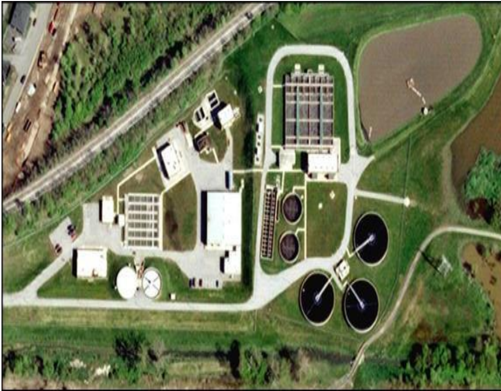
Figure (I.8) : Usine de traitement des eaux de West Lafayette
