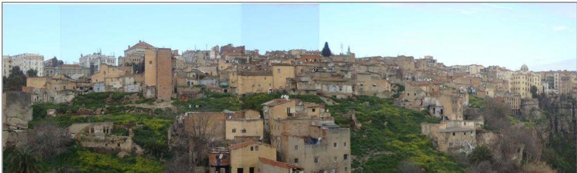
Figure 1.1 : Quartier El-Souika à Constantine, un exemple de tissu urbain traditionnel. Auteur inconnu. Source : Direction de l'urbanisme et de l'architecture et de la ville, Constantine, 2016.
