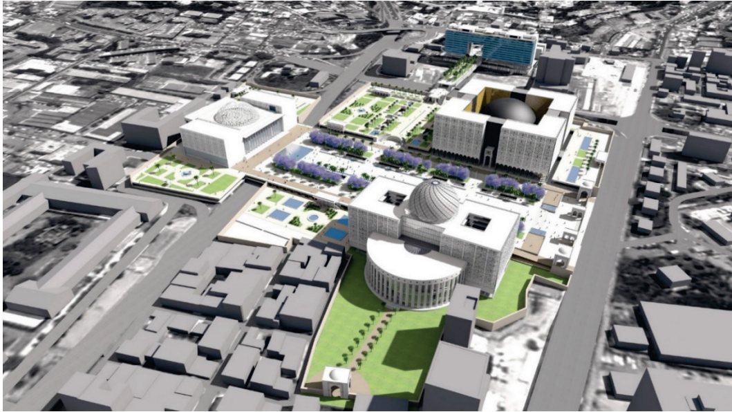
Figure 7.36 : Vue générale sur les espaces et les aménagements extérieurs (BM, 2014)
