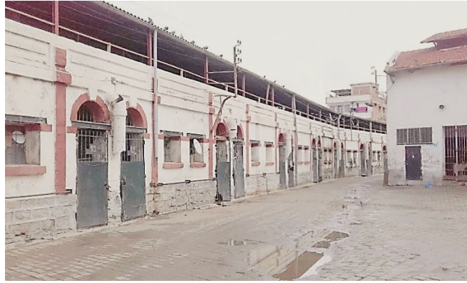
friche infrastructurelle, Abattoirs de Ruisseau à Alger (auteur)
