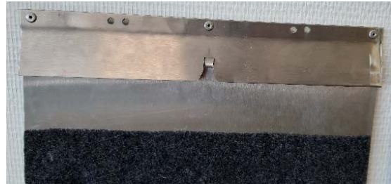
(h) pose du support de soutien du système de distribution de l'eau
