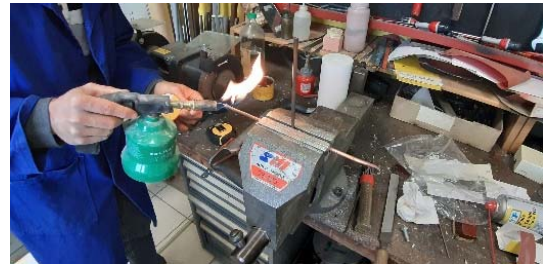
(b) soudure du système de distribution de l'eau
