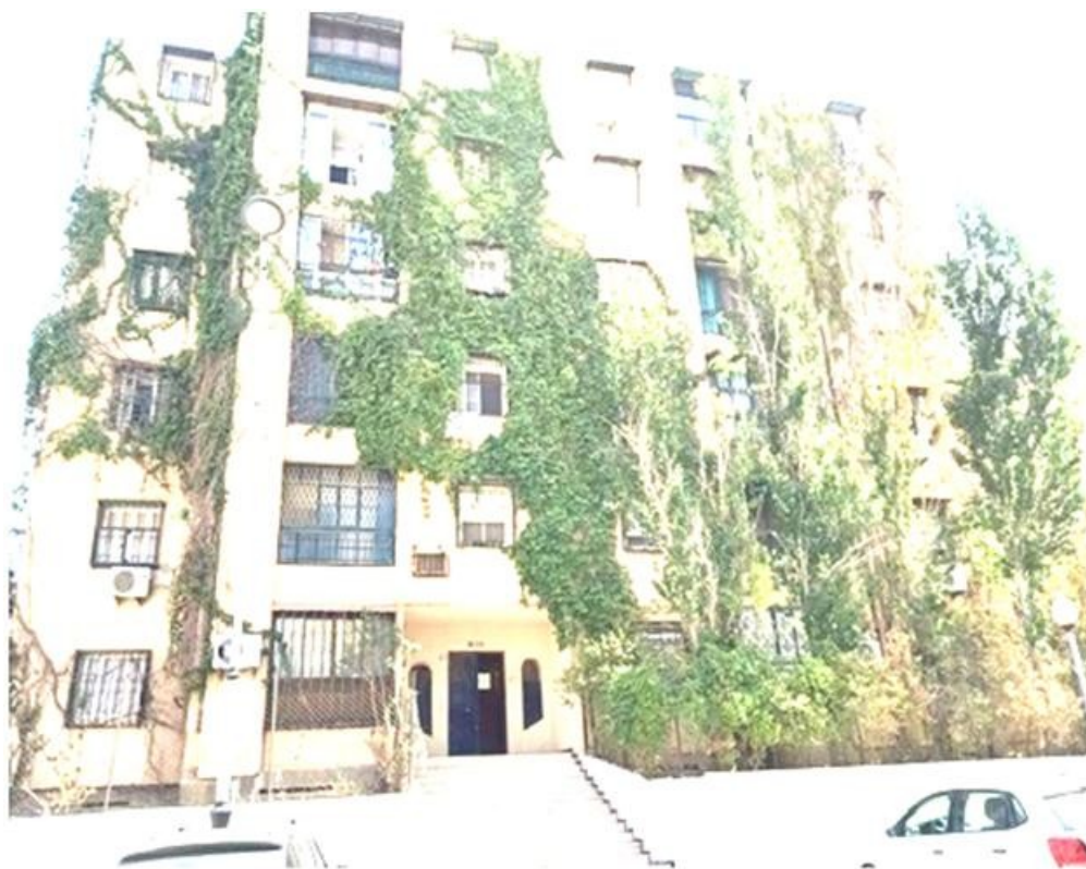
Figure IV. 4 : Bâtiment objet d'étude
