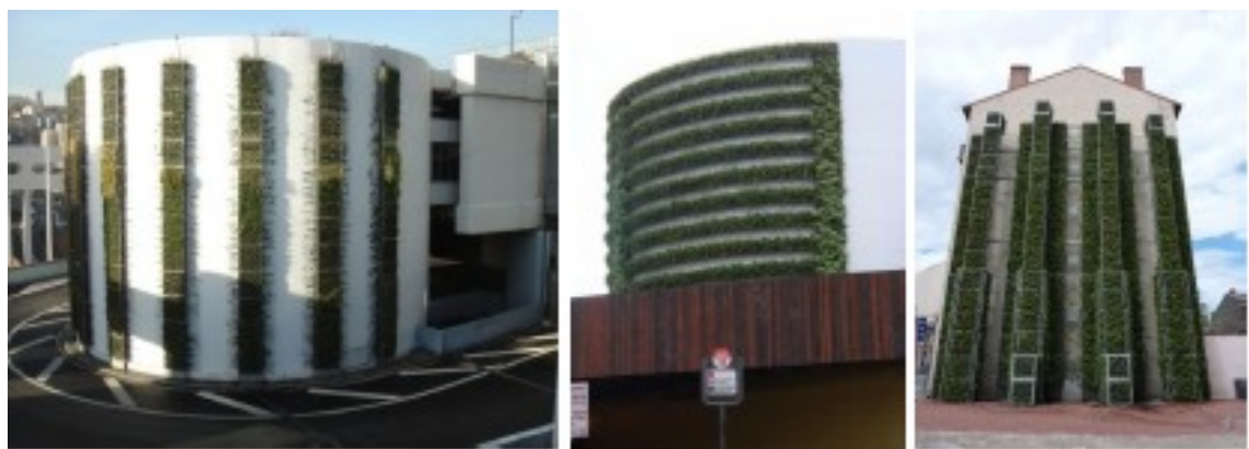
Figure I. 9 : Murs dépolluants à la gare de Perrache à Lyon (à gauche) et à l'entrée de Villeurbanne (à droite)
