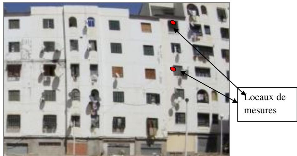
Fig. VI.15 : Position des locaux de mesures ( Auteur )
