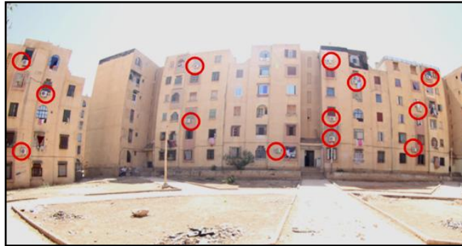
Fig.IV.30 : Climatiseurs présents dans la station B (Auteur).
