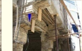
STRUCTURE DE PLANCHER
