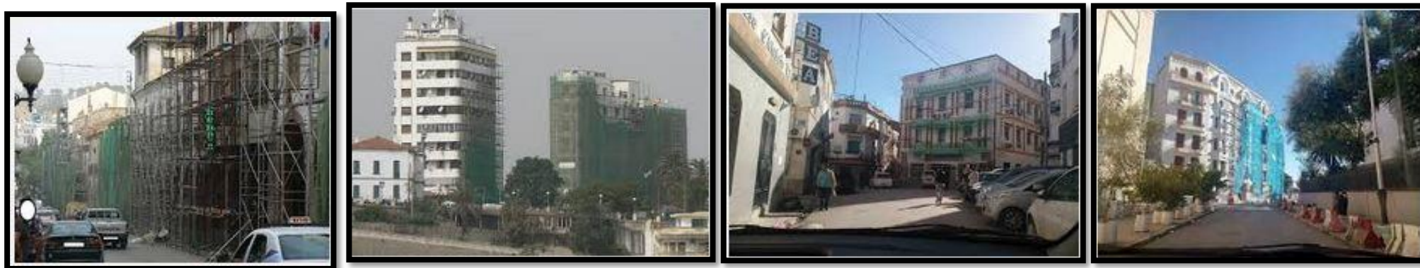
Image 4 : Ravalement des façades des immeubles du centre-ville de Constantine
