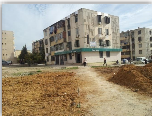
Image 21: des rez-de-chaussée de bâtiments transformés en commerce après abattements des murs porteurs (Auteur)
