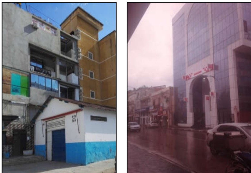
Figure 6.6: La matière, entre ancienne et nouvelle bâtisse à L'Avenus de l'ALN
