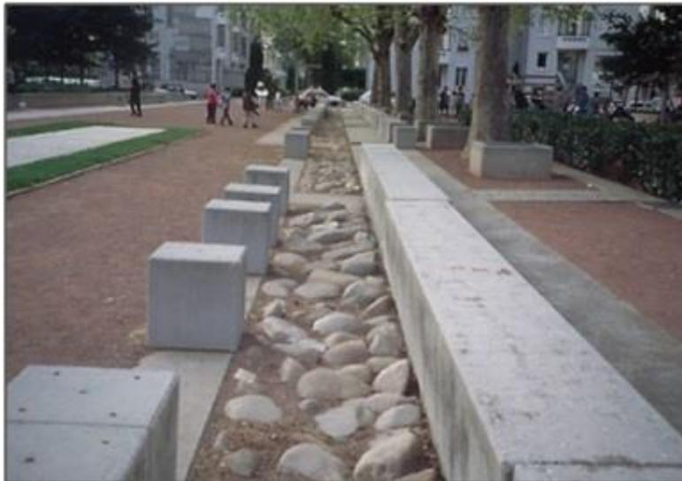
**Fig2.6 : Exemples d'aménagements d'axes de circulation libres avec des matériaux filtrants (VARCIN CALIX, 2007).**
