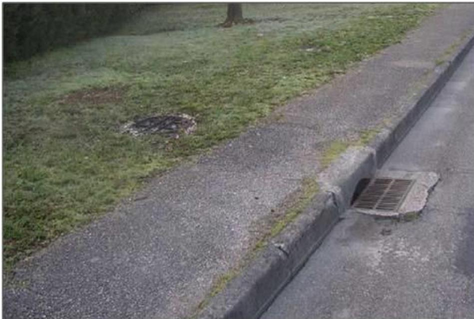
**Fig6.5 : Avaloir conduisant les eaux pluviales de voirie vers le puits d'infiltration, (Chassieu, non Daté).**
