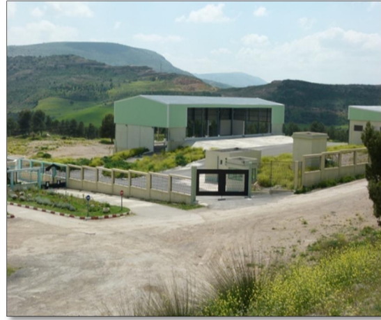
شكل رقم(104): محطة التحويل قبل الحرق
