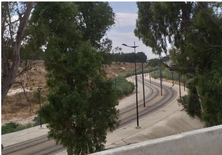
Figure 5.40 : Ligne de tramway, commune de Constantine
