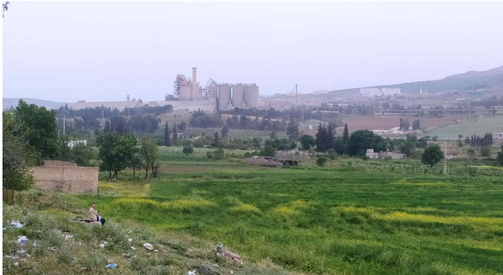
Figure 5.53 : Usine du ciment à Hamma Bouziane
