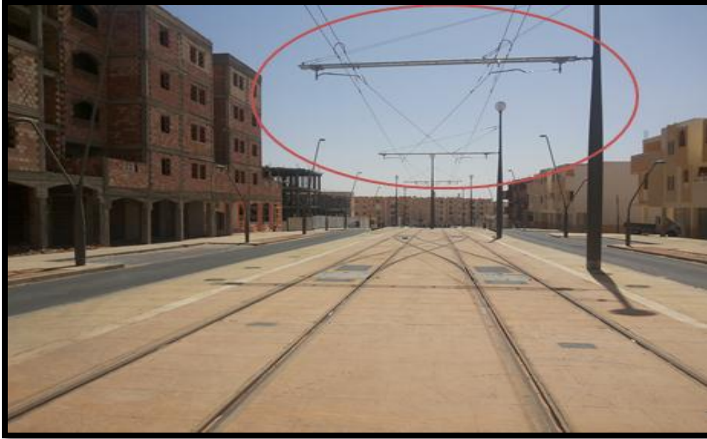
الشكل رقم 25: صورة لأسلاك التغذية الجوية بالطاقة الكهربائية لترامواي ورقلة
