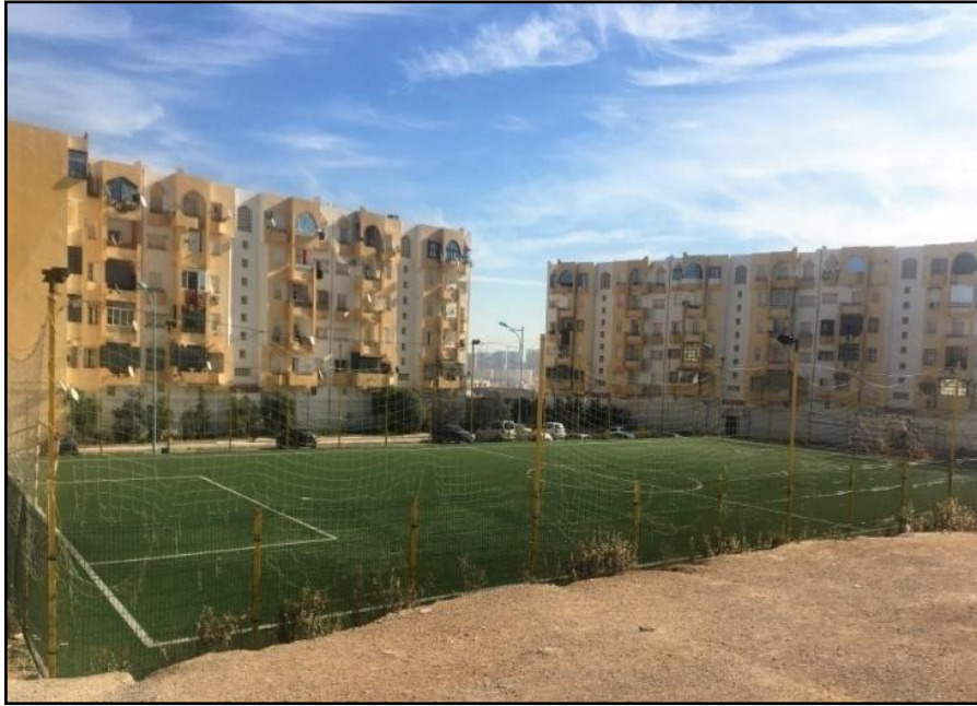
Figure 6.36 : Un stade de quartier consacré nettement à un public masculin Source : (Auteur, 2019).
