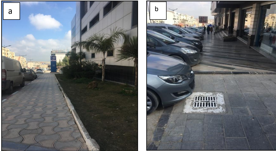
Figure 6.14 ( a, b): Trottoirs bien aménagés sur les bords des projets d'investissement Sources : (Auteur, 2018).
