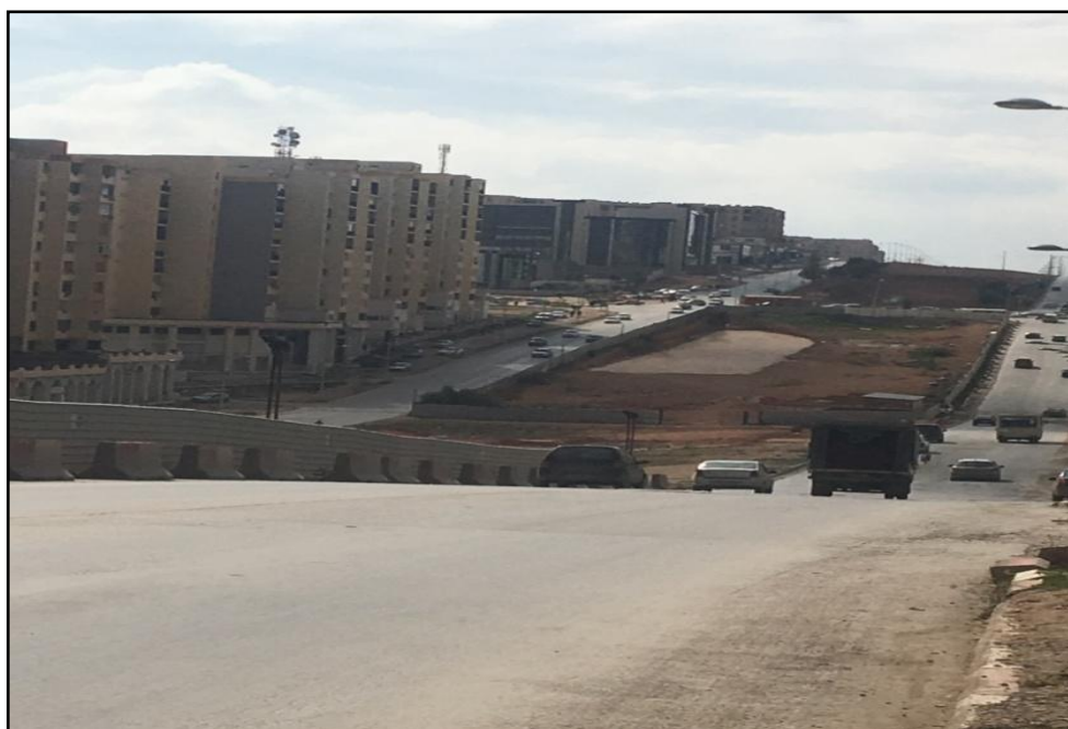
Figure 6.6 : Le terre-plein du boulevard est occupé par les travaux du tramway.
