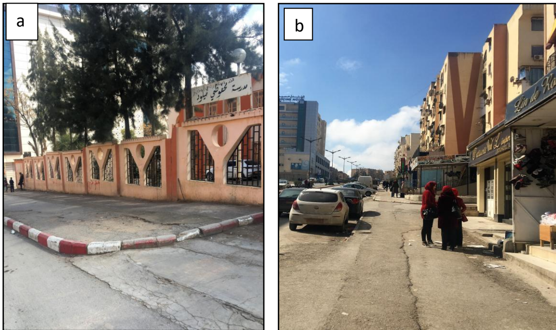
Figure 6.13 (a, b) : Des larges trottoirs dégradés avec des traitements de sol camouflés Source : (Auteur, 2018).
