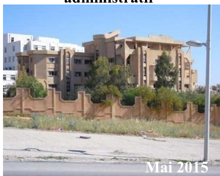
Photo N°10 : le bloc administratif
