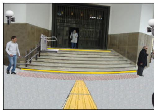
Photo 77: hôtel des finances, l'accès extérieur après l'aménagement
