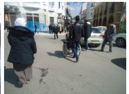
Photo 20 : Place Amirouche trottoir dévers > 2%
