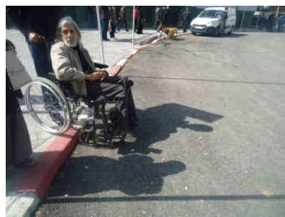
Photo 18 : Place Amirouche trottoir non abaissé
