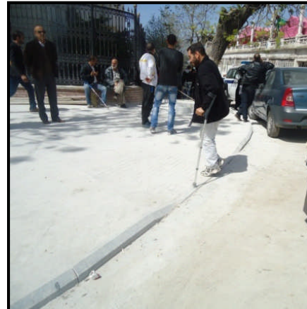
Photo 50 : Avenue B Boulaïd, un revêtement et un abaissement adapté.
