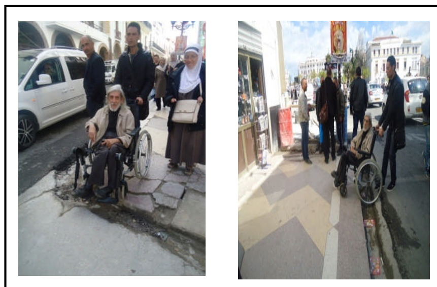
Photos 22 : La sortie de la rue Abene ramdane : mauvais état du pavé et le trottoir encombré
