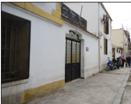
Photo 74: la DAS, l'accès extérieur avant l'aménagement
