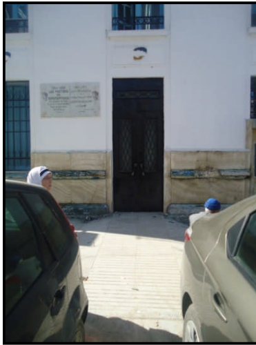
Photo 30 : la grande poste : un accès facile pour les fauteuils roulants.
