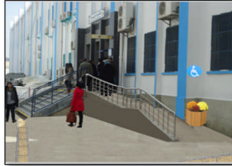
Photo 79: bureau de poste, l'accès extérieur après l'aménagement
