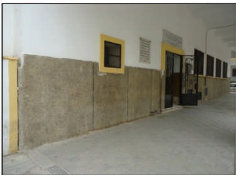
Photo 82: la direction d'éducation, l'accès extérieur avant l'aménagement
