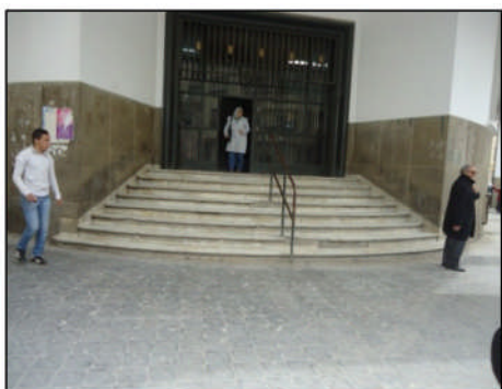
Photo 76: hôtel des finances, l'accès extérieur avant l'aménagement
