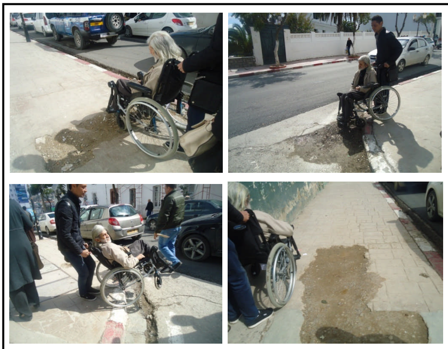
Photos 16 : Rue John Fitzgerald Kennedy, Trottoir inadapté et au mauvais état
