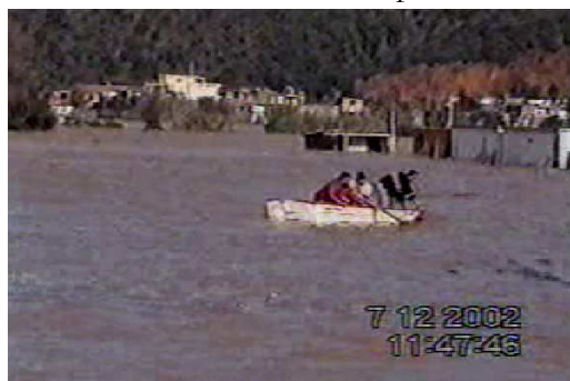
Figure N° 14 : Route Nationale N°09 pendant la crue de 2002
