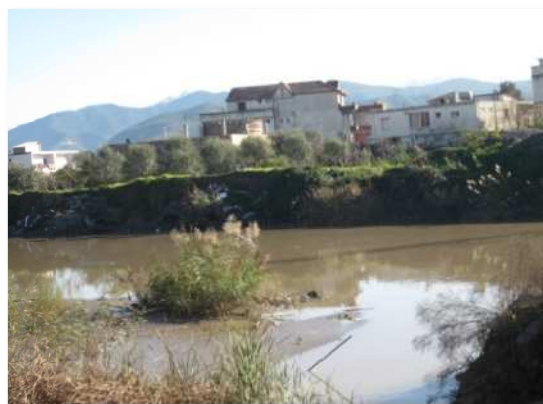
Photo N° 17: Oued Soummam : urbanisation de la zone inondable
