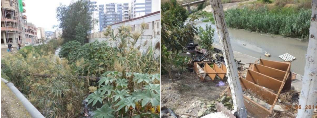
Photo N°16 : Engorgement des cours d'eau par la végétation et les décharges sauvages
