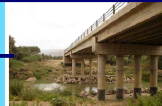
Ouvrage de liaison-pont
