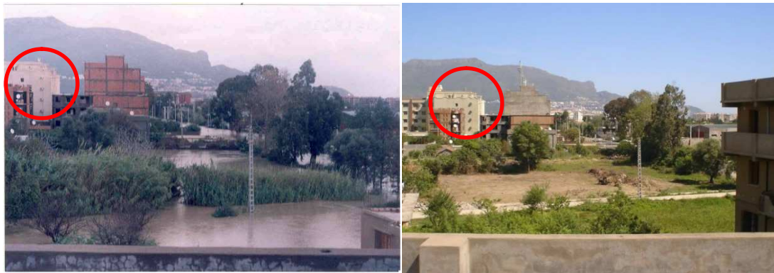
Photo N° 08: Quartier Iriahène, crue 2002, Avant et après l'inondation
