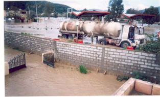
Station de service situé sur la RN 9, totalement inondée
