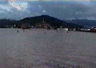
L'entrée et les alentours de l'université de Bejaia (campus Aboudaou) inondés complètement.
