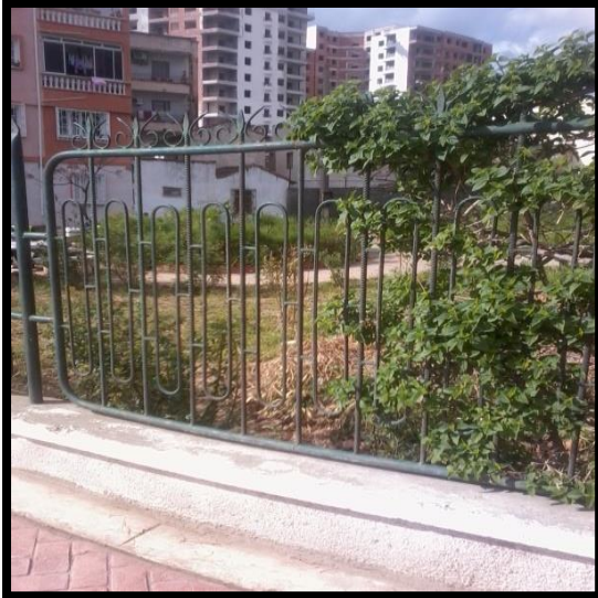
Fig. n° 17 : clôture du jardin Soummam I
