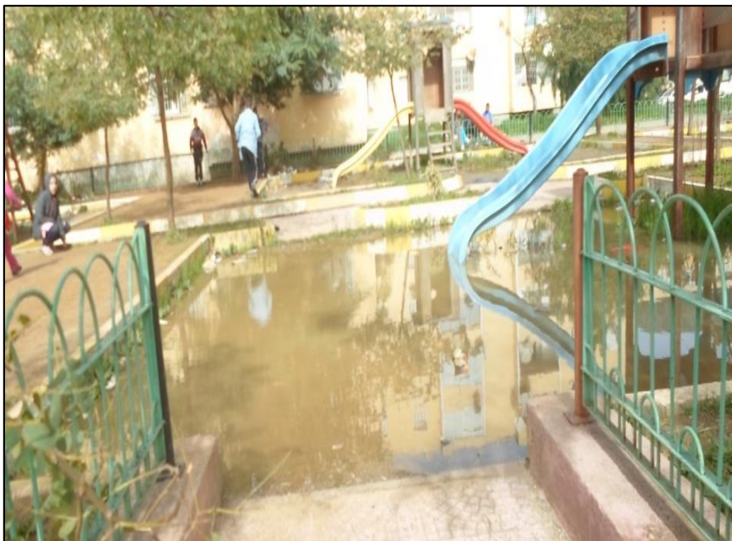
Fig. n°43 : air de jeu en mauvaise état
