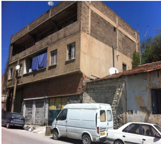
Ajout étage et modification red de chaussée
