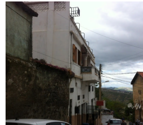
Habitat informel malgré son état de finition; emprise du sol et le non respect de vis-à-vis
