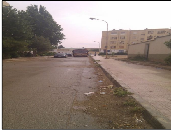
Photo N°42 : Manque de l'entretien des voiries. (Cité Fatima Zahraâ)
