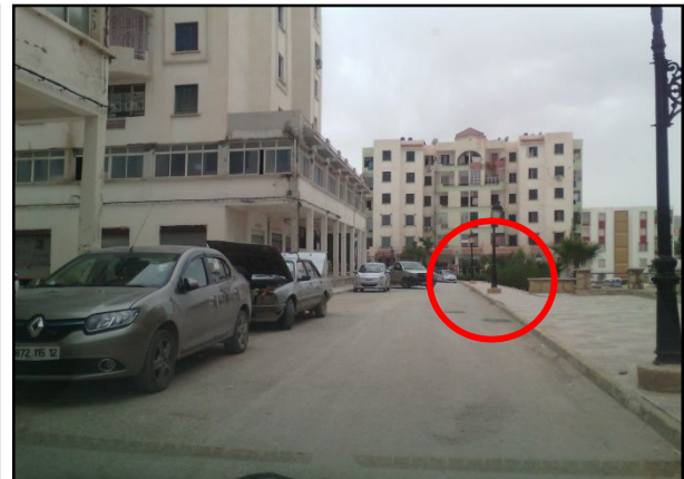
Photo N°74 : trottoir encombré par les candélabres (cité des 580 logements AADL).
