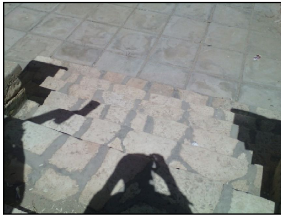
Photo N°94 : Les revêtements naturels (pierre). (Cité des 580 logements AADL).
