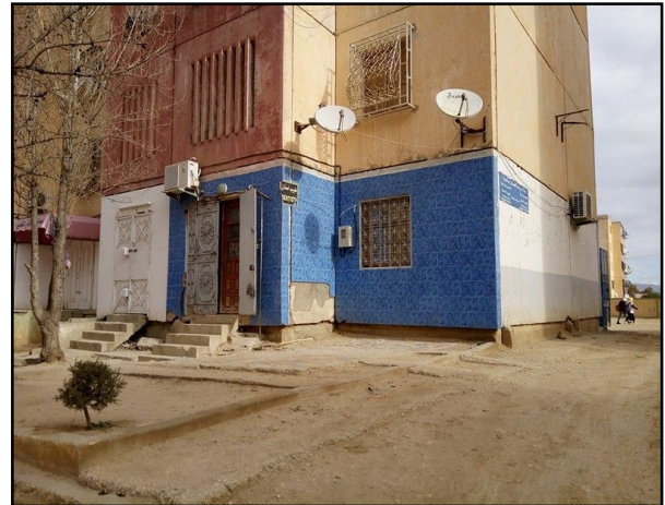
Photo n°34 : Intervention sur la façade (ravalement), (Cité Fatima Zahraâ).
