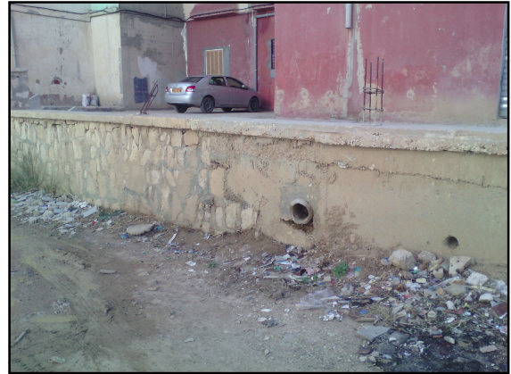
Photo N°97 : Canal des eaux usées. (Cité des 580 logements AADL).
