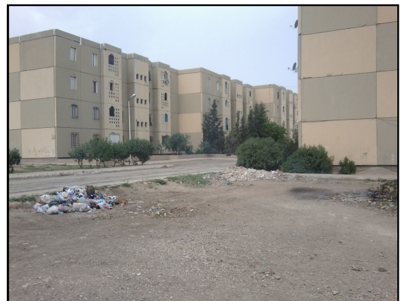
Photo N°44 : Une poubelle à ciel ouvert. (Cité Fatima Zahraâ)
