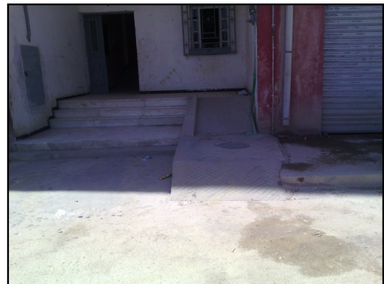
Photo N°76 : Traitement des pentes au profit des PMR (Cité des 580 logements AADL).
