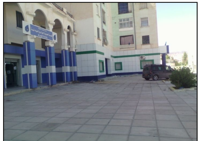
Photo n°36 : Intervention sur la façade (ravalement), (Cité AADL).
