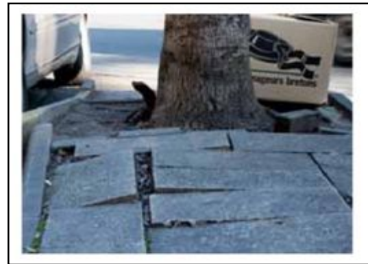
Figure n° 25 : Un arbre détériorant le trottoir.
