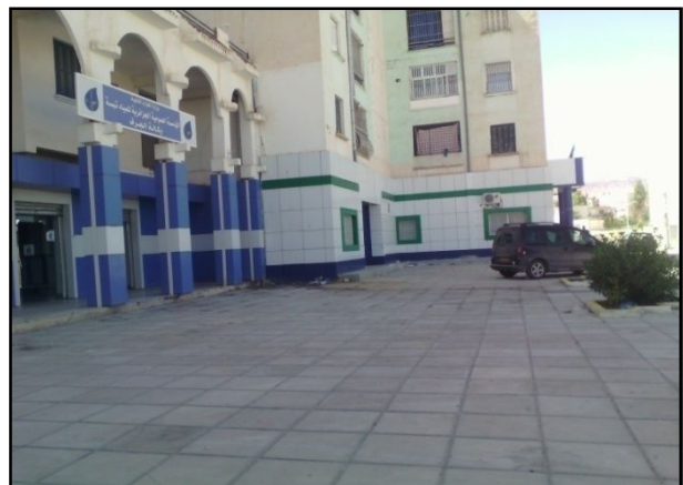
Photo N°93 : Dalle en béton (Cité des 580 logements AADL).
