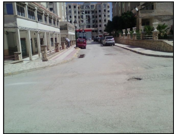
Photo N°91 : Les revêtements enrobés. (Cité des 580 logements AADL).
