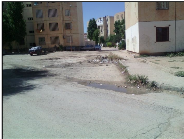
Photo n° 105: Difficulté d'évacuation des eaux pluviales (Cité de Fatima Zahraâ).
