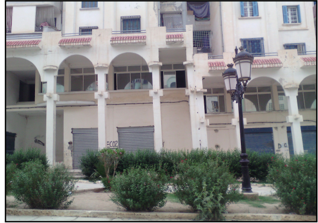
Photo N°52 : Locaux fermés. (Cité 580 logements AADL).
