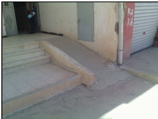
Photo N°75 : Traitement des pentes au profit des PMR (Cité des 580 logements AADL).
