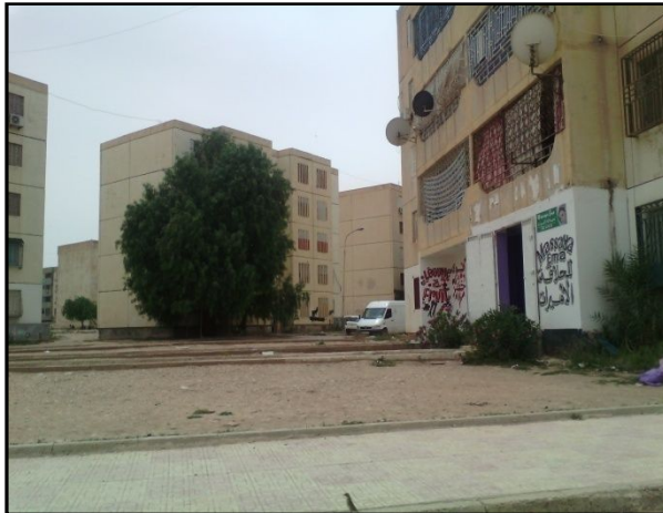
Photo n°33 : Intervention sur la façade (peinture), (Cité Fatima Zahraâ).
