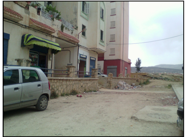
Photo N°72 : Voies non goudronnées (Cité AADL.)
