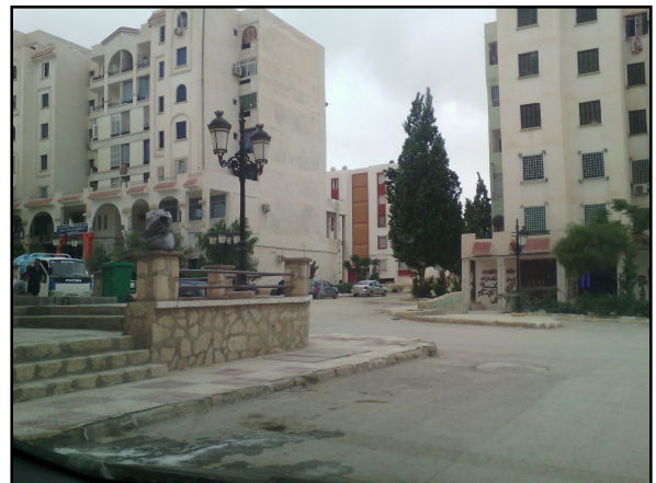
Photo N°41 : Carrelage en béton sur les trottoirs Cité des 580 logements AADL).
