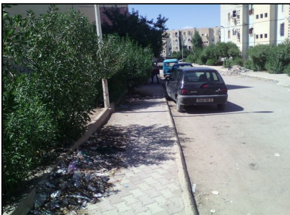
Photo N°92 : Les revêtements modulaires. (Cité Fatima Zahraâ).
