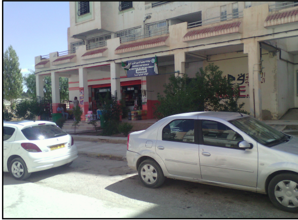
Photo N°51 : Présence des locaux commerciaux. (Cité 580 logements AADL).
