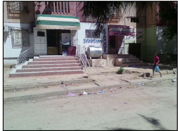
Photo N°50 : Transformation des pièces de logement en des locaux commerciaux. (Cité Fatima Zahraâ).
