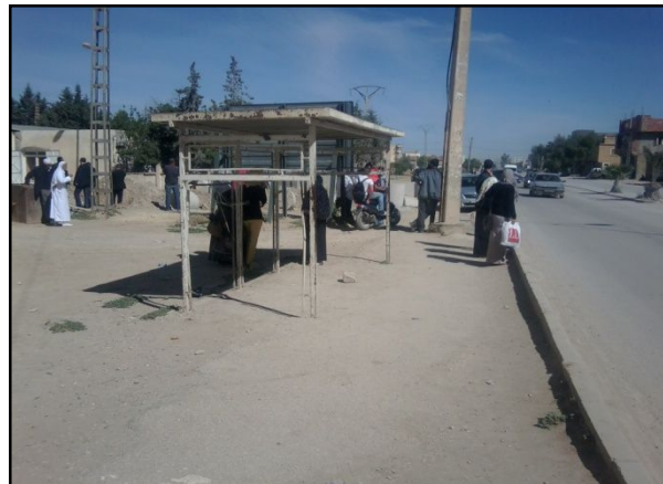
Photo N°87 : Abribus dégradé dans la cité Fatima Zahraâ.
