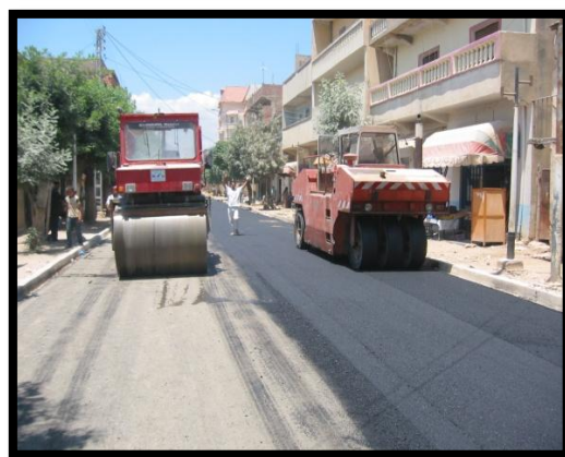
الصورة رقم (34-35) تعبيد الطرق
