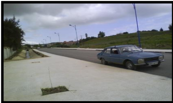
الصورة رقم (65) طريق البركة بعد إنجازه
