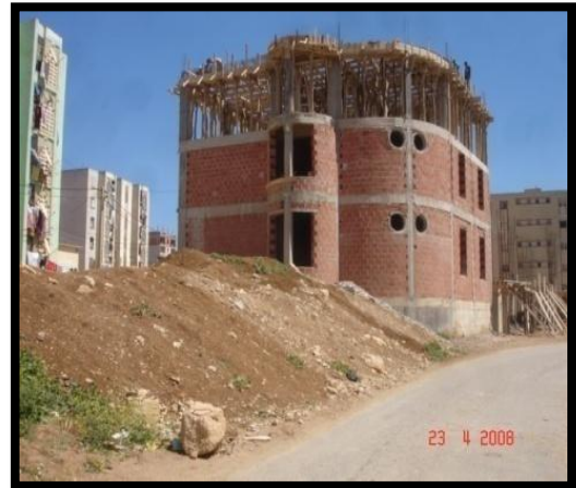
الصورة رقم (94): مركز تجاري أثناء الإنجاز
