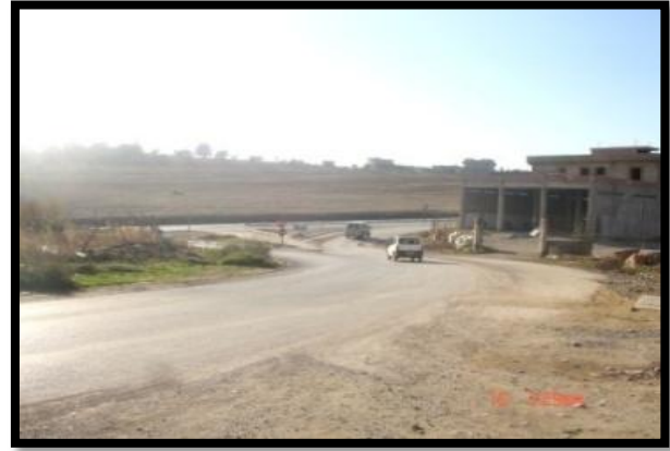
الصورة رقم(54): المدخل الغربي قبل عملية التحسين
