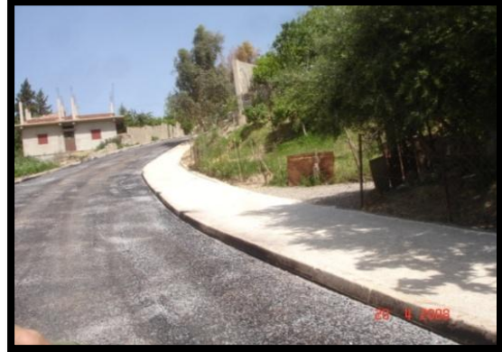
الصورة (41-42-43-44) تعبيد الطرق
