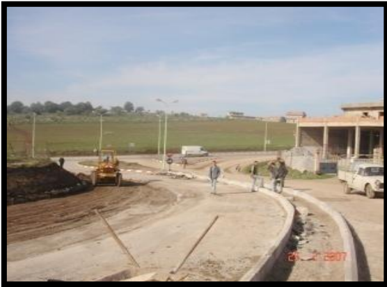
الصورة رقم(55): المدخل الغربي اثناء عملية التحسين
