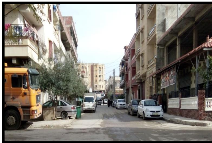
الصورة(74) التهيئة الحضرية لحي 125 قطعة
