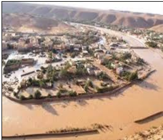
Figure n°21: La palmeraie de Ghardaïa et la digue (Photographie : ASAL)
