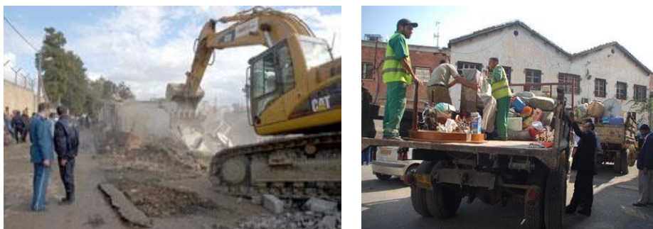
Photo VII-18 et 19: Démolition et évacuation des ménages du quartier BARDO (Source : La Tribune - 21 décembre 2008)
