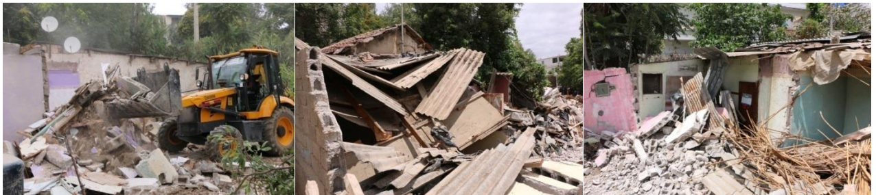
Photo VI-12 : La démolition des baraques érigés sur le site "Chalets des pins" le jour du relogement (03 juillet 2017) (Source : page facebook de la wilaya de Constantine, 2017)
