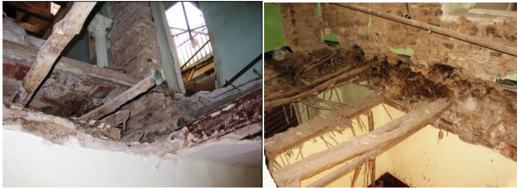
Photos VII-10 et VII-11 : Planchers de typologie traditionnelle (Source : Azazza 19 , 2014)
