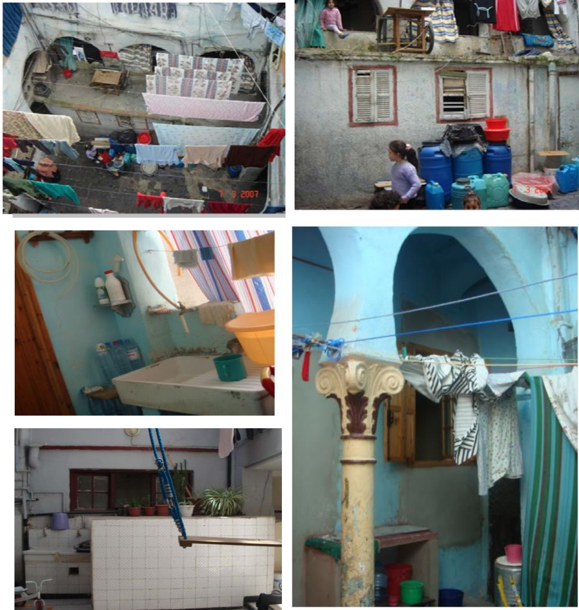
Photo VII-8: l'appropriation des espaces intérieurs de la maison traditionnelle : les transformations opérées par les usagers pour adapter l'espace à leurs besoins : création d'une salle d'eau au niveau de : Skifa , Patio et la Galerie (Source : Boufenara , PPSMVSS de la vieille ville de Constantine,2012)
