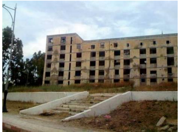
Photo VI-7 : Immeubles désaffectés sis à la cité Boudraâ-Salah, vidés en 2013 en attente de démolition (Source : article el watan Cité Boudraâ Salah : Les bâtiments désaffectés bientôt démolis)
