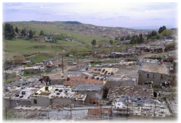
Photo VII-4 : à gauche un bidonville construit en dur (uniquement en Parpaing et en brique) à El barda, à droite des bidonvilles construits en parpaing avec une toiture en tôle ondulée (bidonville djabellah) ( (source :page wilaya de Constantine : Nait Amar, N, 2015)
