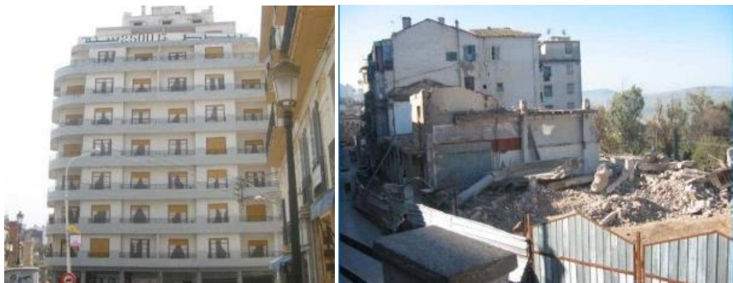
Photo VII-13: Maison Cadot Sise À Belouizdad Avant Et Après Démolition : (Source : Archives DUC ,2005)
