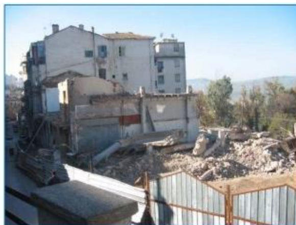
Photo II-11 : MAISON CADOT SISE A belouizdad après démolition, (source archives DUC ,2005)
