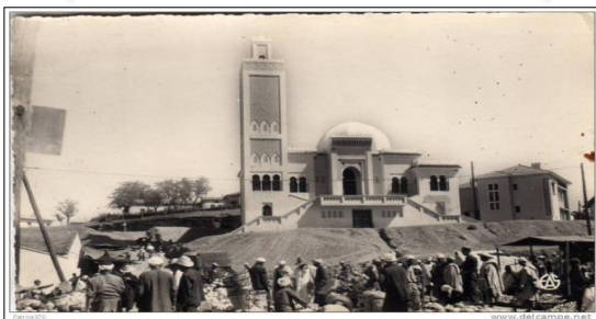
[ Photo n° 01: Mosquée Ibn Badis. ]
