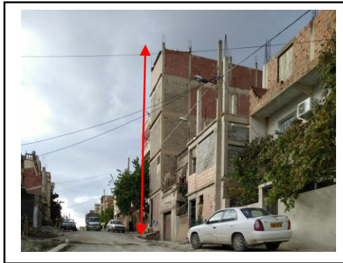
صورة رقم (28) : بناية طابق ارضي + 4 طوابق
