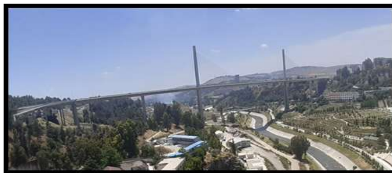
Figure 54 : Le Viaduc Trans-Rhumel.
