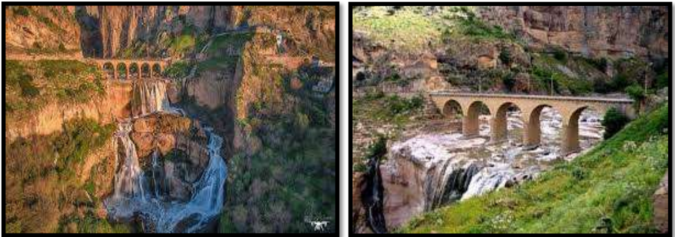
Figure 42: l'état actuel du pont des chutes.
