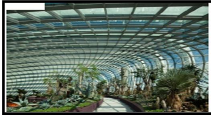
Figure09 : structure verre/acier dans la serre
