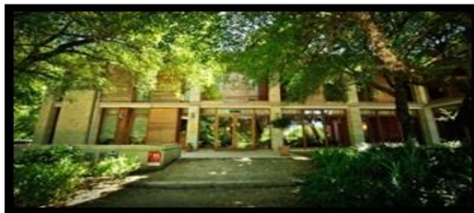
Figure14 : les façades en vitre
