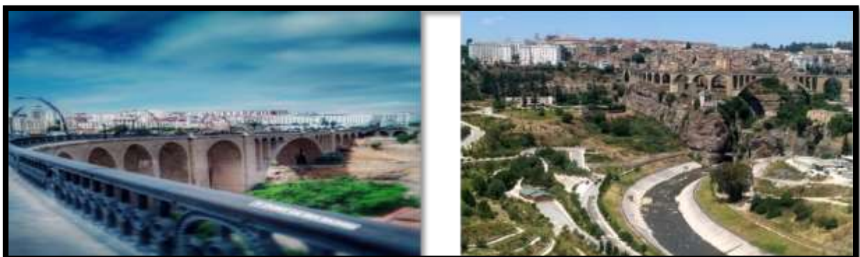
Figure 50 :L'état actuel du Pont de Sidi Rached.
