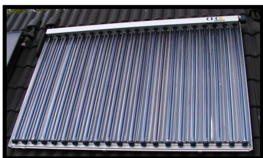
Figure 62 : panneau solaire thermique
