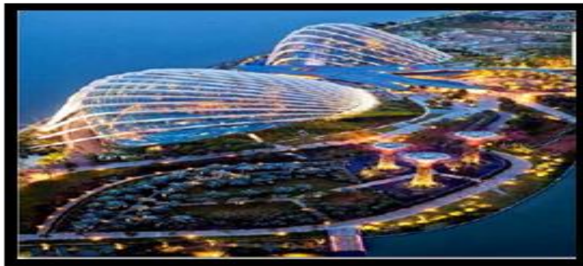
Figure04 : vue aérienne de l'éco-parc Singapour
