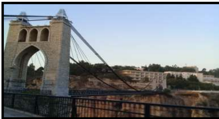
Figure 44 : L'état actuel du pont de sidi M'cid.
