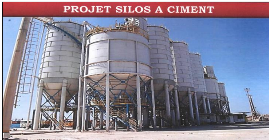
Fig 5.11 : Projet silos à ciment (Source : EPJ).
