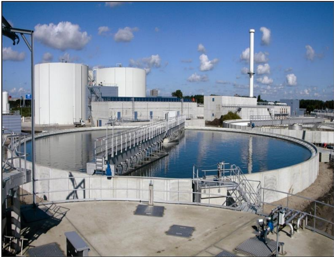
Fig 4.21 : Unité générale de traitement de l'eau ( source : AQS)
