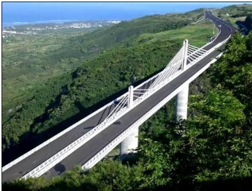
Fig 3.8: Etat d'avancement des Travaux : lot ouvrages d'art (Source :Algérie presse service).
