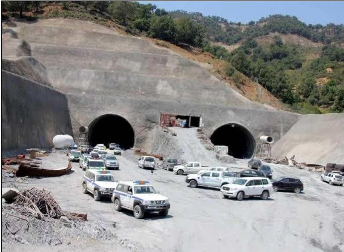
Fig 3.5: Etat d'avancement des travaux : lot tunnel
