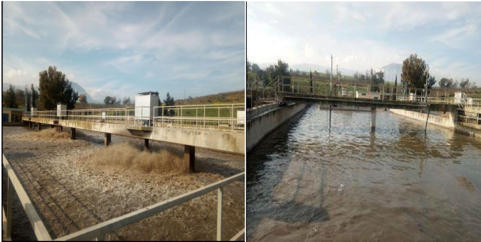
Figure III. 6 Bassins d'aération[35] Figure III.7 Bassins d'anoxie[35]
