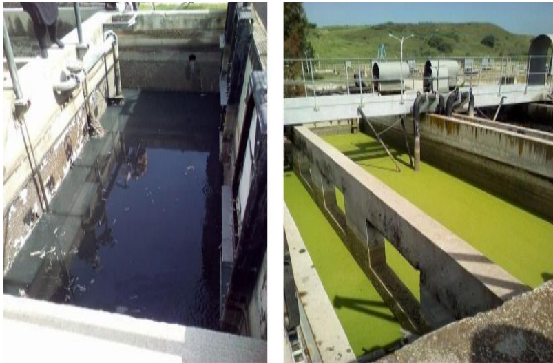
Figure III.5. Séparation du sable et de la graisse[37]
