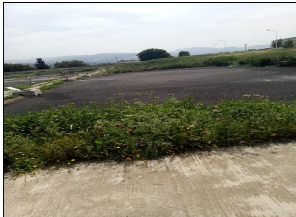
Figure III.10 Les lits de séchage des boues[35]
