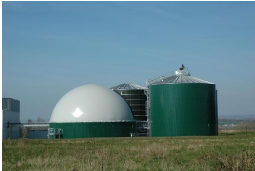
Figure IV.3. Digestion avec stockage intégré du biogaz[42]
