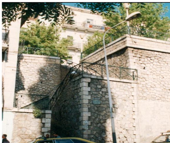
Fig. 33 : Escalier urbain à Constantine ville
