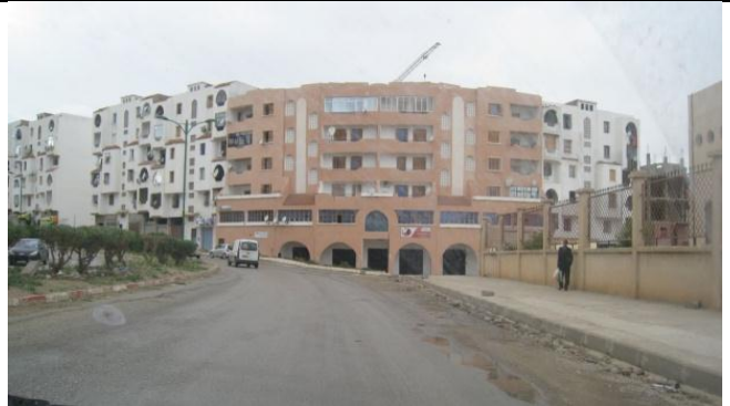
Fig. 32 : Bâtiment frontal à la ville Ali-Mendjeli
