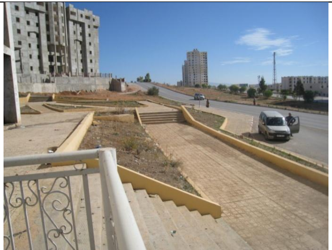
Fig. 34 : Escalier urbain à ville Ali Mendjeli
