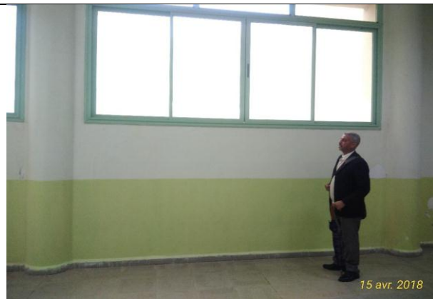
Fig.25 : Au RDC les fenêtres hautes ne permettent pas la connexion avec la verdure du patio
