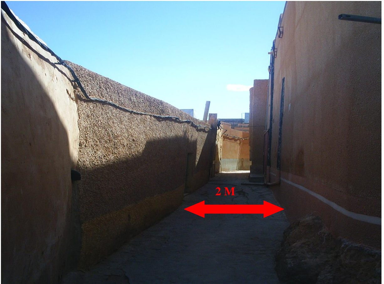
Figure VIII.5 Exemple de rue secondaire situé au Ksar de Ghardaïa
