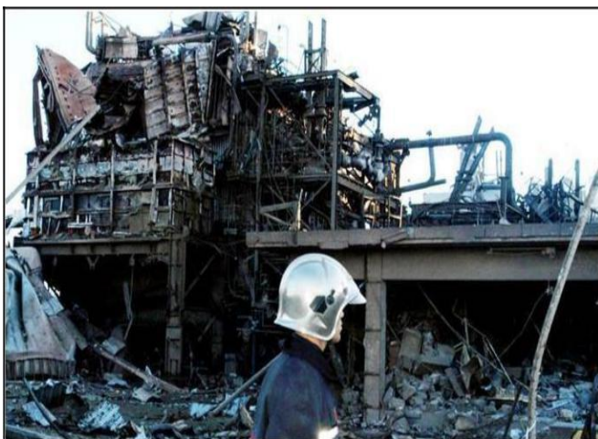
Figure I.4: Explosion Skikda Janvier 2016
