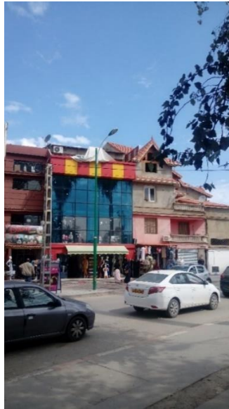
Photo 28 : Habitation individuelle transformée en bazar
