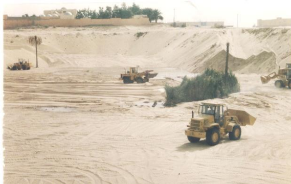
Figure 35 : Les grandes opérations de remblaiement par bulldozer.
