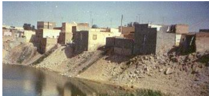
Figure 41 : Les constructions s'agglutinent autour des ghouts ennoyés.
