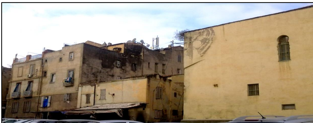
Ph.39: La façade Nord-ouest de la rue Kahoul Mohamed.
