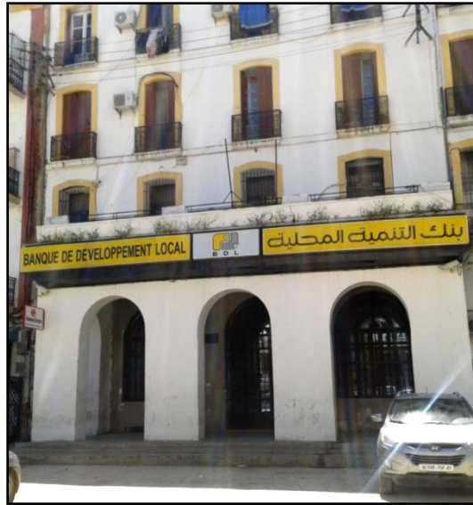
Ph.28: La banque de développement local. Source : Auteur, 2014.
