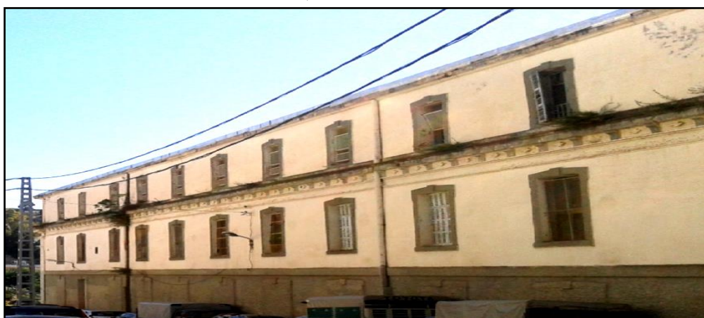
Ph.40: L'arrière-façade du lycée Reda Houhou.
