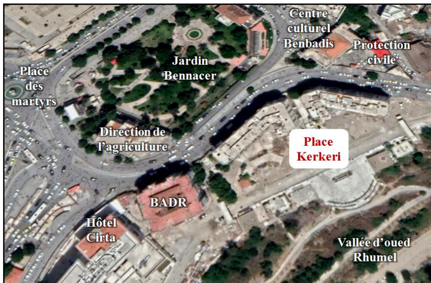
Fig.12: La place Kerkeri dans son environnement immédiat.
