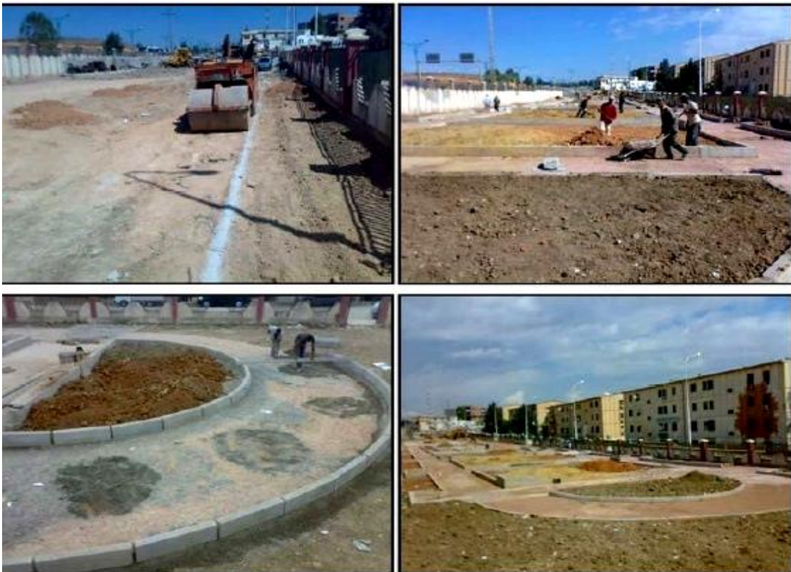
Ph.19, 20, 21, 22: Le chantier d'aménagement du jardin des Frères Ferrad en 2010.
