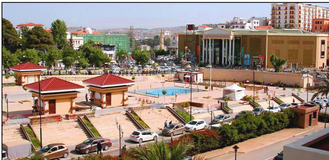
Ph.93: La rénovation de la place Ahmed bey.
