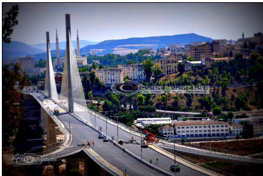
Photo 1 : Pont Salah Bey
