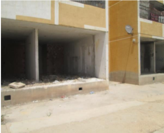
Figure 30 : cliché du point 3 parcours Bleu Source : auteur, 2017
