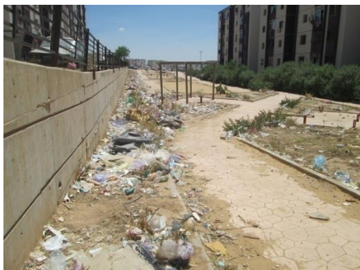
Figure 33 : espaces extérieurs reflétant les déficits de la gestion Source : auteur, 2017
