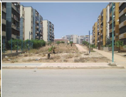
Figure 36 : manque flagrant d'aménagement extérieur et de gestion Source : auteur, 2017
