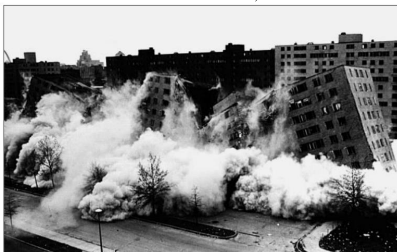
Figure 7: Pruitt-Igoe en cours de démolition, à perte de 300 millions de dollars. Source : Oscar Newman, 1996
