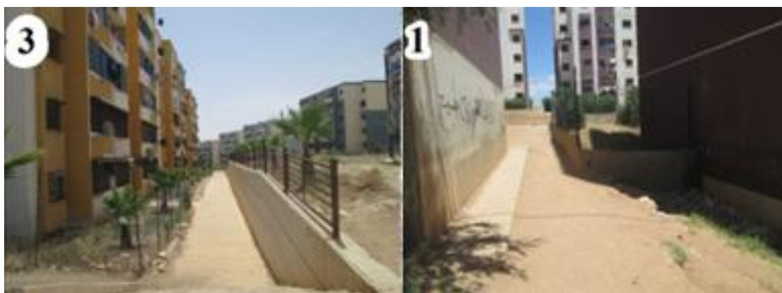
Figure 47 : cliché représentant les espaces 3 et 1 du parcours Rouge. Source : auteur, 2017
