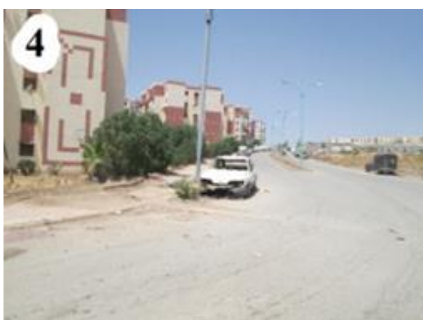
Figure 46 : cliché de l'espace 4 parcours Orange Source : auteur, 2016
