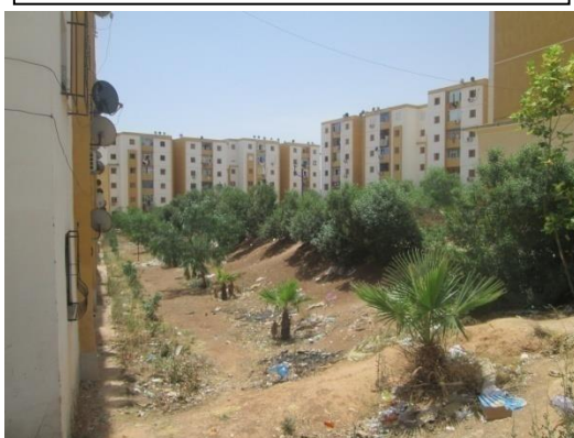
Figure 35 : aménagement extérieurs empêchant la visibilité au sein des espaces extérieurs Source : auteur, 2017
