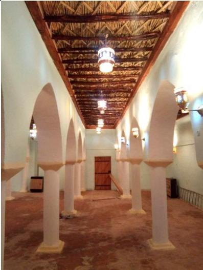
صورة 6. 59: السقف بعد الترميم و تثبيت السقف الخشبي المزيف.
