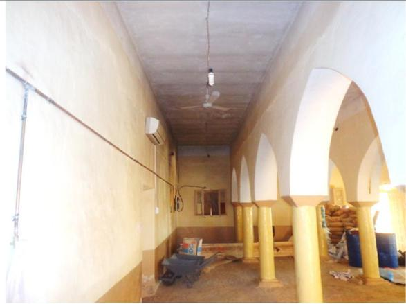
صورة 6. 43: سقف خرساني يحل محل السقف التقليدي.
