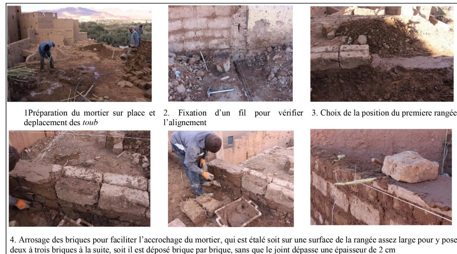
Figure V.21 : Etapes de construction d'un mur en brique de terre toub
