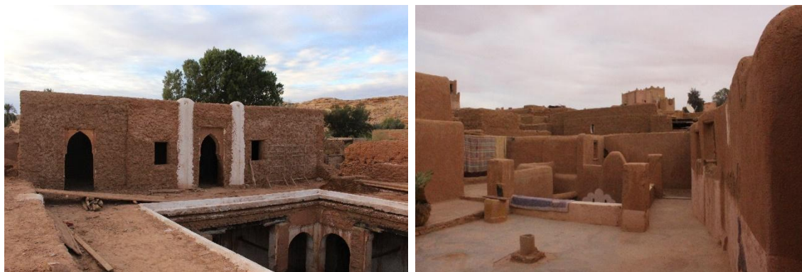
Figure V. 33: terrasses rénovées à ksar Kenadsa et à ksar Taghit Source : Auteur 2018
