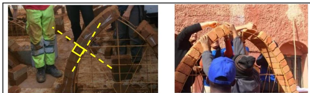
Figure V.46 : démonstration de la mise en œuvre d'un arc en brique Source : Auteur 1-Archi'terre 2015 ; 2- CAPterre 2021
