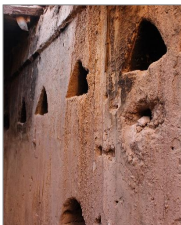
Figure VI. 5: niches de rangement, ksar Moughel Source : Auteur 2016
