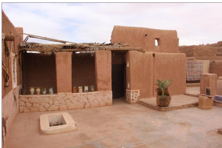
Figure VI. 8: terrasse d'une maison récemment réhabilitée, avec l'ouverture de ayn-eddar Ksar Taghit Source : Auteur 2016
