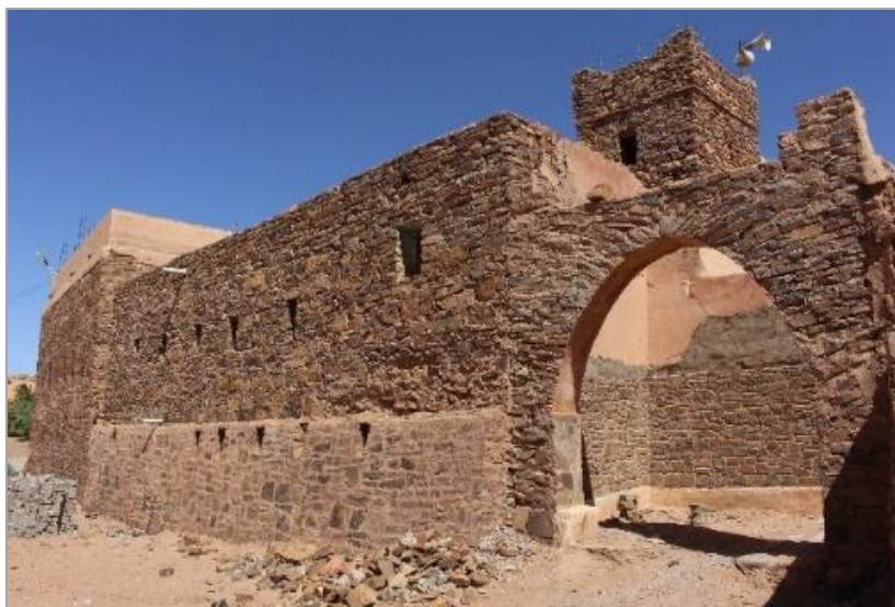
Figure VI. 28: Kasbah de ksar Kenadsa Source : Auteur 2019
