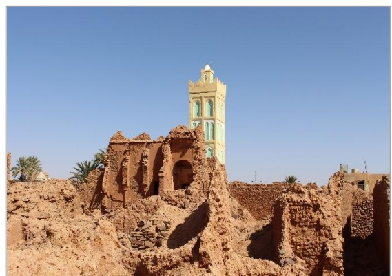
2- l'état des habitations autour de la mosquée de Kénadsa.
