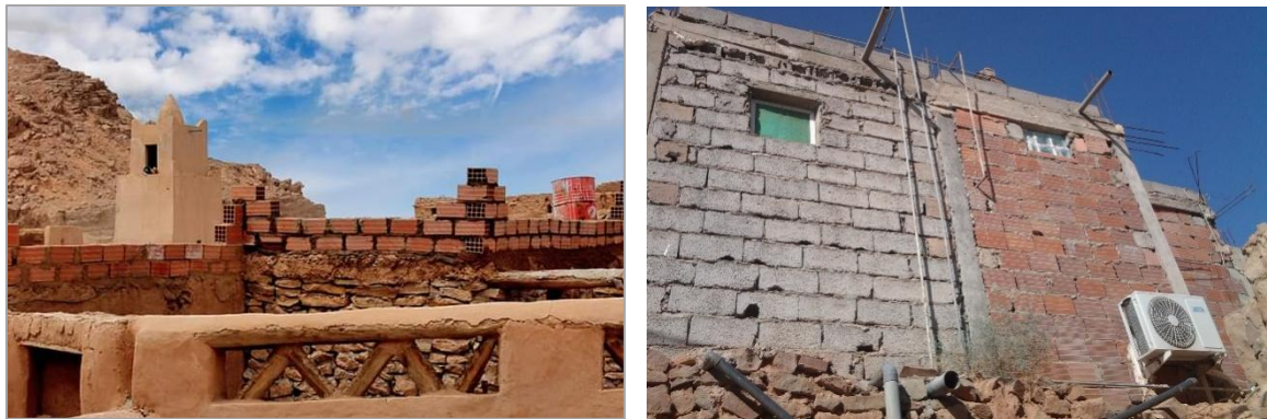
Figure II. 4: Utilisation de nouveaux matériaux non-compatibles avec la terre (Taghit, Kénadsa) Source : à gauche (abdelkhaleq,2020), à droite auteur 2016
