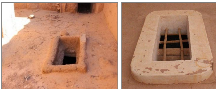
Figure VI. 2: Diferents types de ayn-eddar vus de la terrasse (photos de gauche et du milieu) ou bien de l'intérieur (photo de droite)
