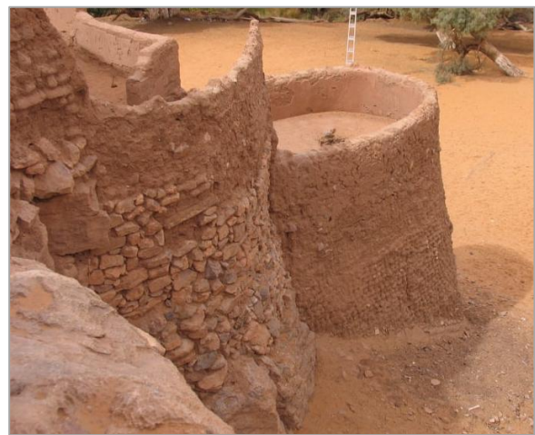
Puits de Ksar Taghit 23 .
