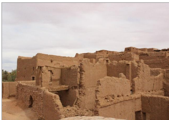
1- vue sur une unité d'habitation a ksar Taghit.
