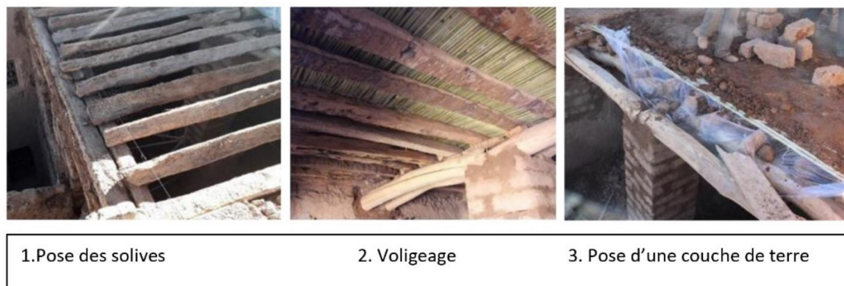
Figure V.29 : étapes de construction d'un plancher Source : Auteur 2021
