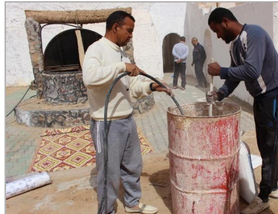
Figure V. 15: Préparation de la chaux pour refaire l'intérieur de ksar Elouata
