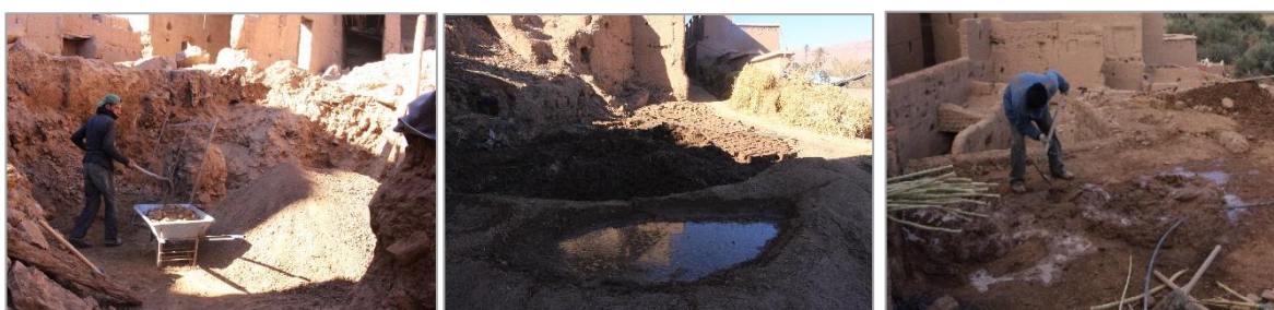
1. tamisage de la terre 2. Humidification de la terre tamisée 3. Malaxage puis utilisation
