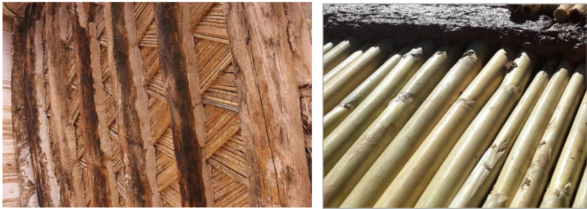
Figure V. 17 : Panneaux en roseau Source : Auteur 2018
