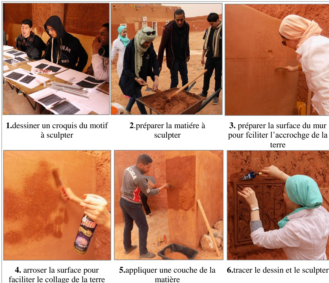
Figure V. 48: Etapes d'exécution d'un ornement sur un support en terre Source : Auteur 2017
