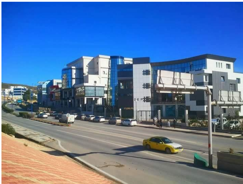
Figure 6- 4 : Photo montrant un ensemble d'équipements publics situés sur la RN 16. Ils ont été implantés dans des poches vides récupérées (DLEP, DL, Trésor, Direction de la main d'œuvre de travail).
