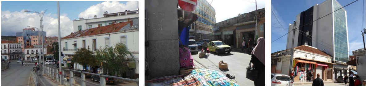
Figure 6- 6: Immeubles commerciaux récents au centre-ville
