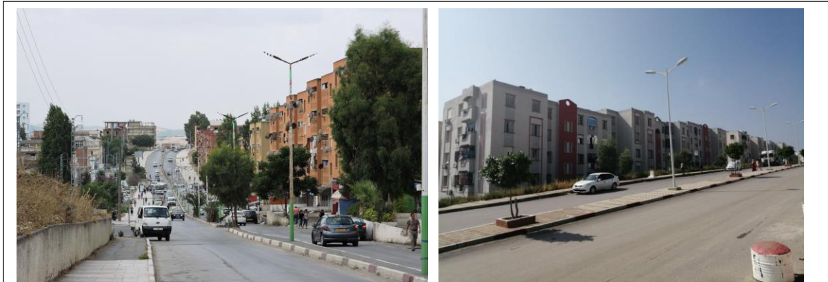
Figure 8- 21: alignement des immeubles collectif de la cité des 1700 logements et de la cité Mchental Saleh le long des rues structurantes.
