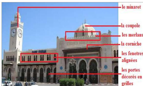
Figure 3.15 : éléments architecturaux employés dans la gare ferroviaire d'Oran (source : https://oran.consulfrance.org/spip.php?rubrique414&debut art actu=5 )
