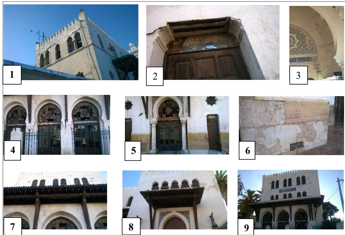
Figure 9.8: Etat de conservation de la gare ferroviaire d'Oran
