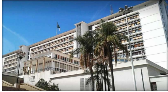
Figure 2.6: Palais du gouvernement d'Alger, arch. Jacques Guiauchain, 1929-1934. (Source : photo, David Rueda, google maps, 2016)
