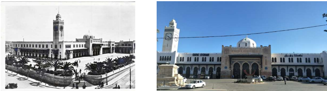
Figure 6.10 : Présentation de la gare ferroviaire d'Oran
