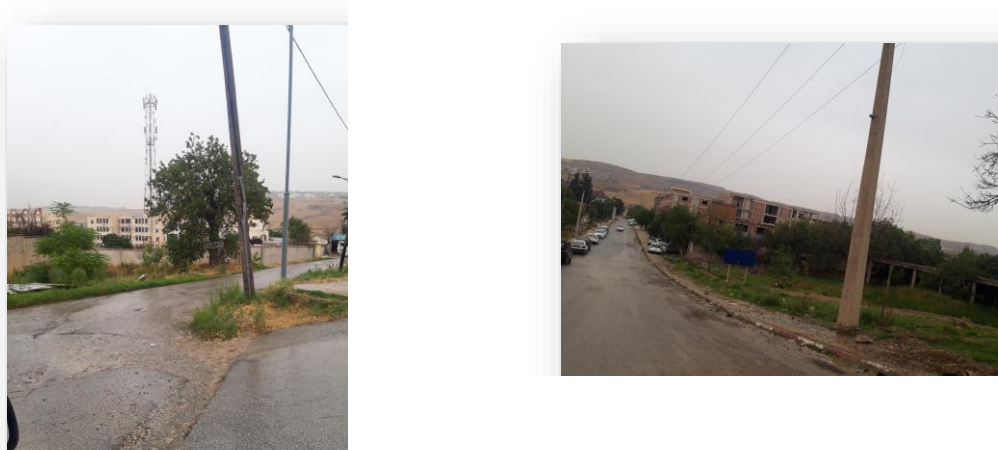
Fig .7.7, fig.7.8: l'état d'assainissement de la zone d'activités El Rhumel
