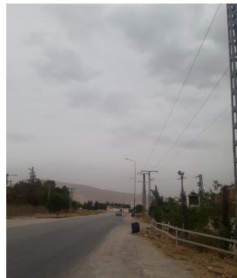
Fig.6.8 : l'état actuel de l'aménagement de la ZI El Tarf
