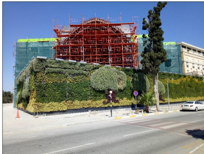
Figure 7.4 l'intégration du chantier a ses alentours grâce à une clôture innovante, source : auteur, Chypre 2018
