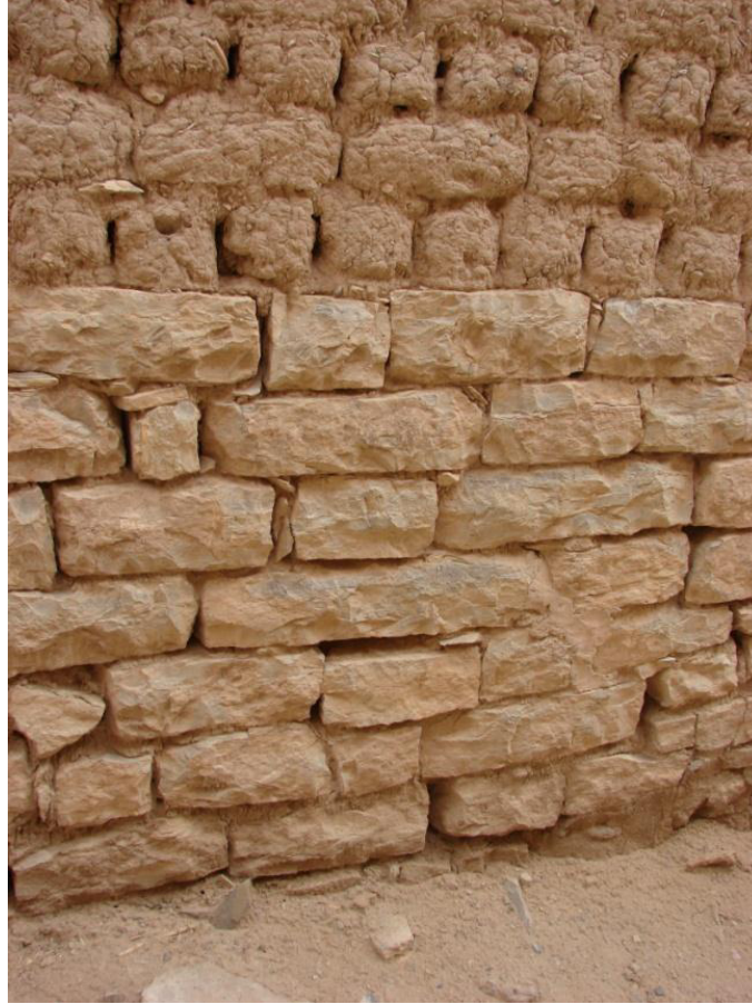
صورة رقم III-17 : جدار من الطوب على قواعد من الحجارة بقصر تاجموت المصدر : تصوير الطالب ، (05 أكتوبر 2017)
