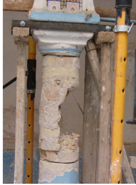
صورة رقم V-35: المرحلة الأولى من تهديم للجزء المتلف من العمود المصدر: تصوير الطالب ، (08 سبتمبر 2016)
