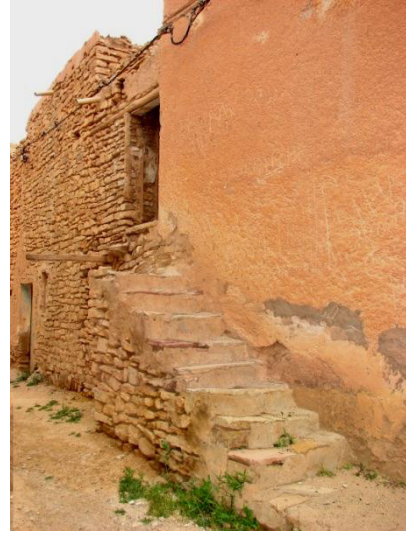
صورة رقم III-20: سلالم منجزة بحجارة ، موجودة باحد دروب قصر عين ماضي ، المصدر : تصوير الطالب ، (05 مارس 2010)
