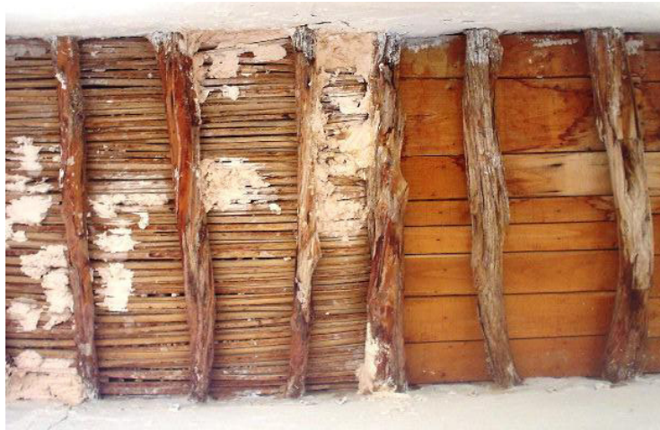
صورة رقم 7- V : ترميم عشوائي و سوء استعمال مواد البناء بمنزل بالأغواط،، المصدر : تصوير الطالب، (06 فيفري 2014)
