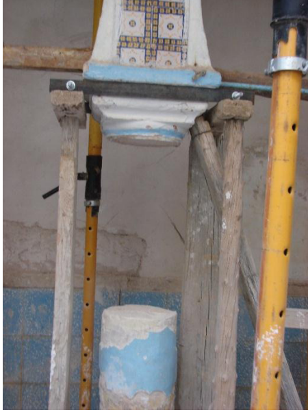
صورة رقم V-36: اكتمال تهديم الجزء المتلف من العمود المصدر: تصوير الطالب ، (08 سبتمبر 2016)
