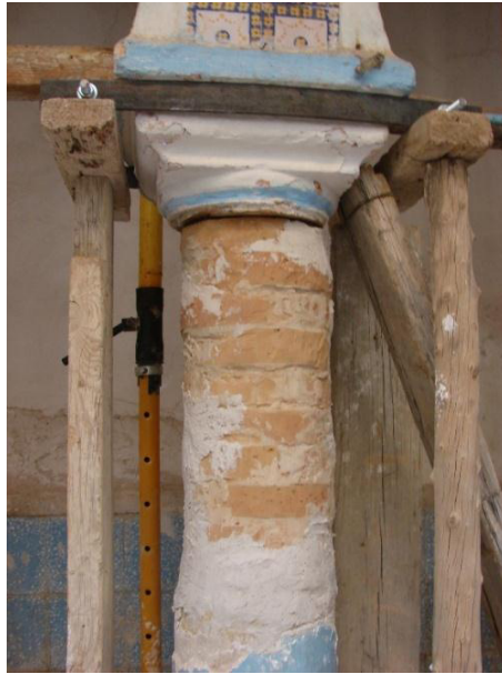
صورة رقم V-37: تثبيت الجزء المستكمل و سدّ الفواصل المصدر: تصوير الطالب، (08 سبتمبر 2016)
