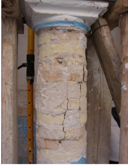
صورة رقم V-29: ظهور الشروخات العميقة في أعلى العمود المصدر: تصوير الطالب، (08 سبتمبر 2016)
