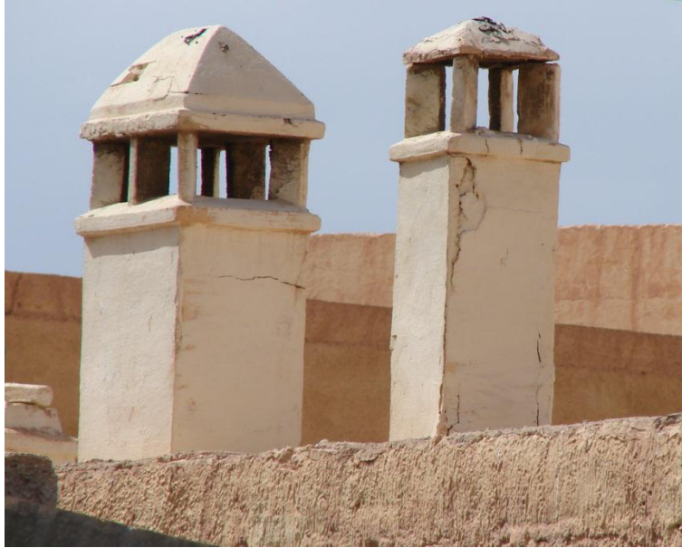
صورة رقم III-12 : مدخنة على سطح منزل بالأغواط المصدر : تصوير الطالب، (08 فيفري 2014)
