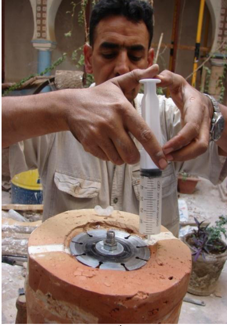
صورة رقم V-34: تنشيت اسطوانتين من الفولاذ بطرفي الجزء المستكمل المصدر: تصوير الطالب ، (08 سبتمبر 2016)
