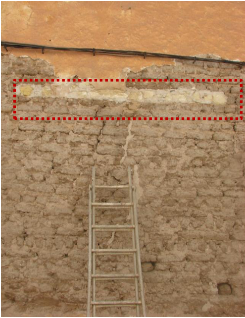
صورة رقم V-19 : ربط بالحجارة لجدار به شروخات بمنزل بالأغواط المصدر : تصوير الطالب، (03 مارس 2016)
