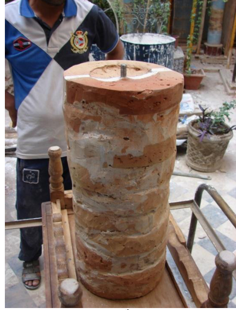
صورة رقم V-33: ربط وحدات آجر العمود حول قضيب فولاذي المصدر: تصوير الطالب ، (08 سبتمبر 2016)
