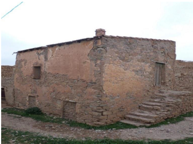
صورة رقم VI-4 : مبنى في حالة تقنية مقبولة، تصوير الطالب (16سبتمبر 2016)
