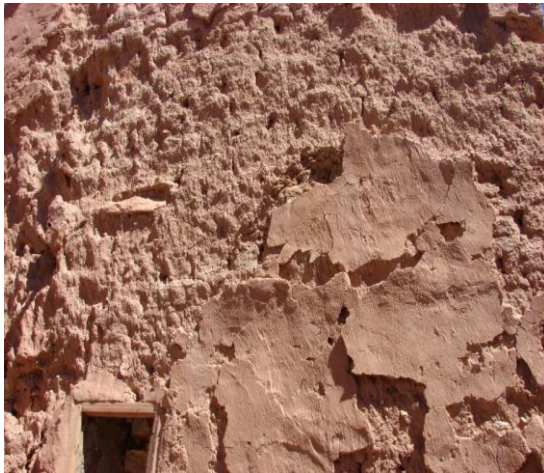
صورة رقم V-17: تلف تغطيات الجدران بقصر الحويطة المصدر :تصوير الطالب،(17 أفريل 2018 )
