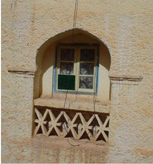
صورة رقم 10-III : معالجة زخرفية أسفل شباك لمنزل بالأغواط ، نلاحظ أشكال تحاكي زخارف بالزربية المصدر : تصوير الطالب ، (06 فيفري 2014)
