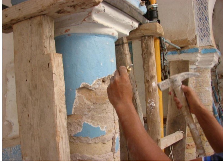
صورة رقم V-28: نزع التغطيات المتواجدة على العمود الحامل المصدر: تصوير الطالب، (08 سبتمبر 2016)
