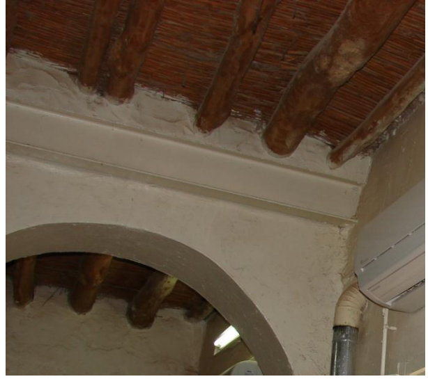
صورة رقم V-22 : تدعيم السقف بعارضة حديدية لتقوية القوس الحامل مسجد بالأغواط - تصوير الطالب ، ( 03 مارس 2016 )
