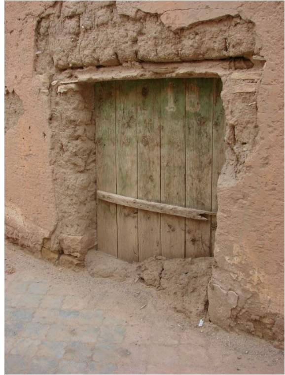
صورة رقم V-8 : تعبيد الطرقات المتكررة أدى برفع مستوى الطريق عن مستوى باب المنزل ، قصر تاجموت ، المصدر : تصوير الطالب ، (05 أكتوبر 2017)
