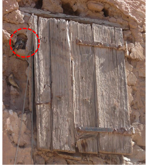
صورة رقم V-11 : أثر الطيور على تلف مواد بناء الجدران قصر الأغواط ، تصوير الطالب ، (03 مارس 2016)
