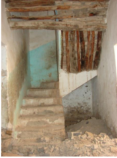
صورة رقم III-21: سلالم محمولة على عوارض خشبية داخل أحد المساكن بقصر عين ماضي . المصدر : تصوير الطالب ، (05 مارس 2010)
