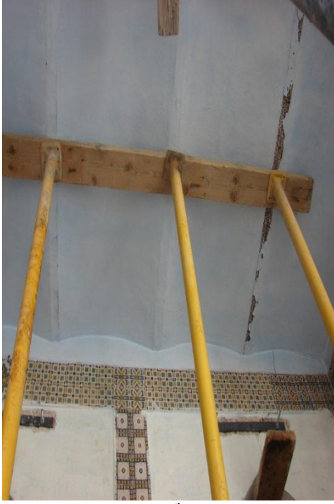
صورة رقم V-27 : تدعيم أقبية السقف المصدر: تصوير الطالب ( 16 أوت 2016 )
