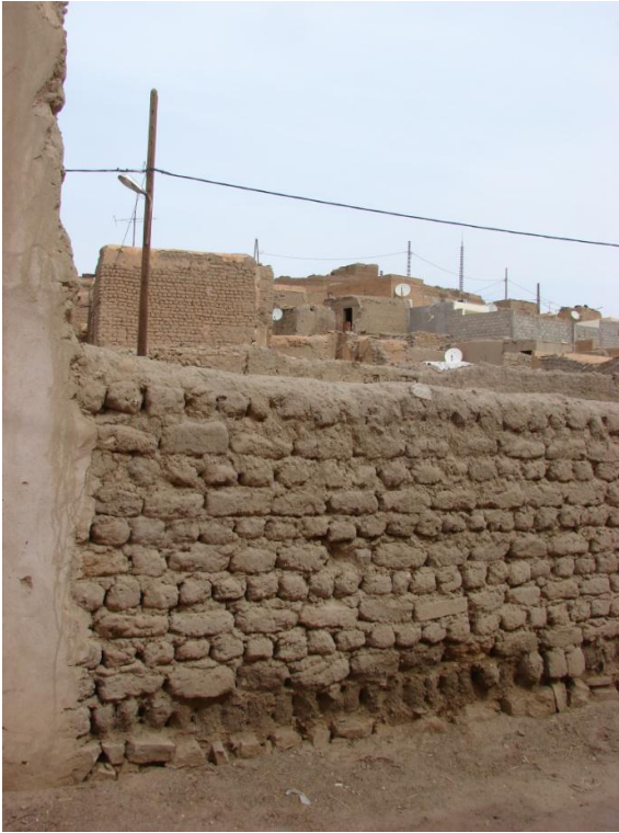
صورة رقم V-9 : تعبيد الطرقات المتكررة أدى برفع مستوى الطريق عن مستوى الأساس مما تسبب في تآكل جدار الطوب ، قصر تاجموت ، المصدر : تصوير الطالب ، (05 أكتوبر 2017)
