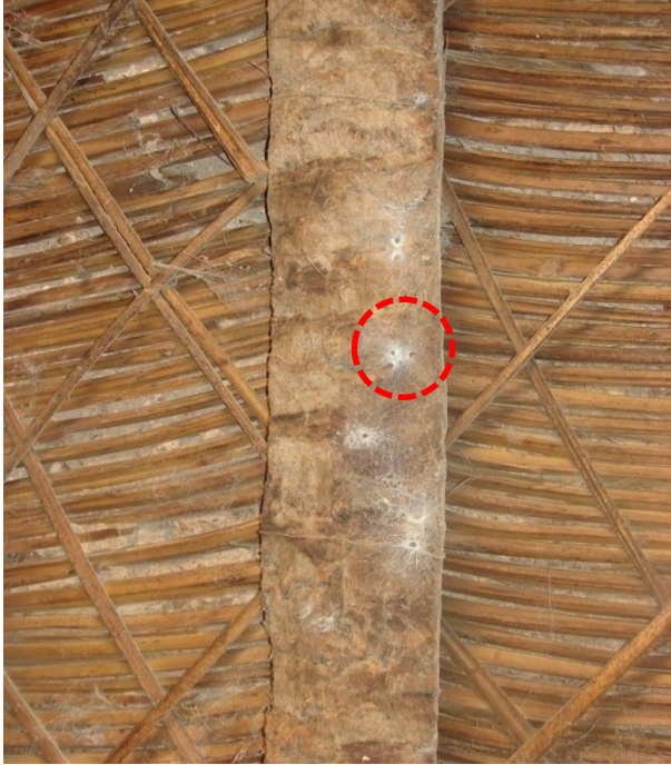
صورة رقم V-12 : أثر العناكب في ثقب و تلف العوارض الخشبية بسقف لمنزل بالأغواط ، تصوير الطالب ، (03 مارس 2016)
