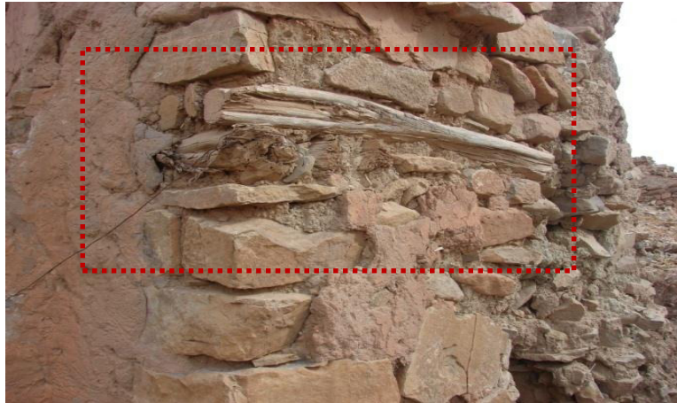
شكل رقم V-21 : ربط جدارين متعامدين بعارضتين خشبيتين - قصر تاويالة ، المصدر : تصوير الطالب، (15 جانفي 2015)
