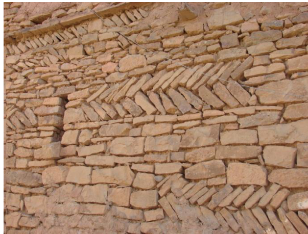
صورة رقم III-15 : جدار من الحجارة ، أجزاء منه مركبة على شكل سنبلية ، قصر عين ماضي المصدر : تصوير الطالب ، (24 ديسمبر 2013)
