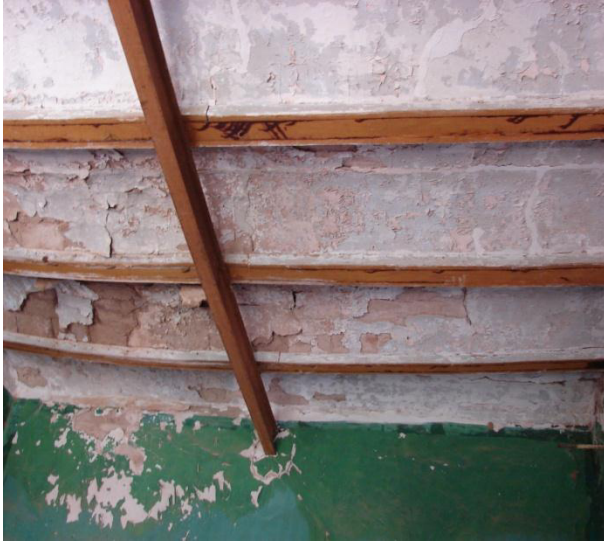
صورة رقم V-23 : عارضة فولاذية بالوسط لسند العوارض الحاملة للسقف قصر كوردان - تصوير الطالب ، ( 10 أمارس 2017 )
