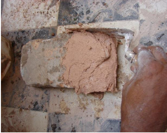
صورة رقم V-32: تحضير ملاط ربط الأجر المصدر: تصوير الطالب ، (06 سبتمبر 2016)
