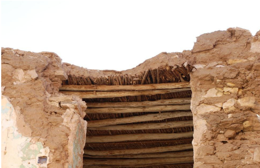
صورة رقم III-19: مكونات السقف بأحد منازل قصرعين ماضي المصدر : تصوير الطالب ، ( 10 أمارس 2017 )
