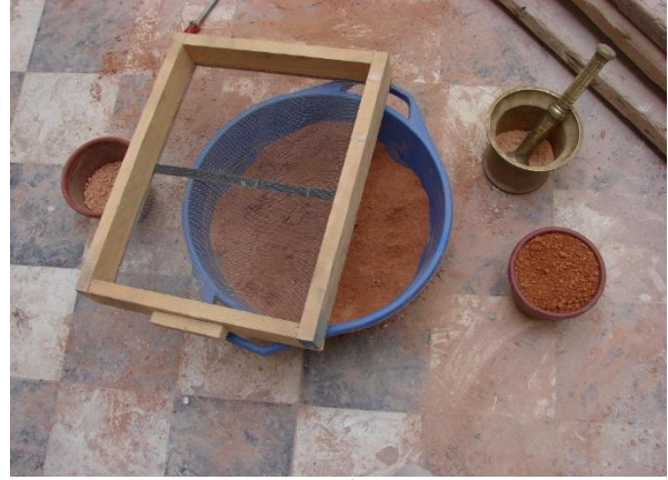
صورة رقم V-31: إعداد الملاط لربط وحدات آجر العمود المصدر: تصوير الطالب ، (06 سبتمبر 2016)
