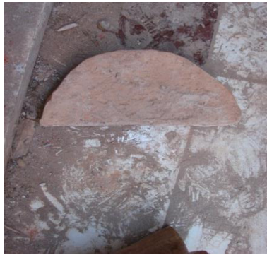
صورة مركبة رقم V-30: تشكيل آجر نصف دائري باستعمال آجر مستطيل الشكل المصدر: تصوير الطالب (06 سبتمبر 2016)
