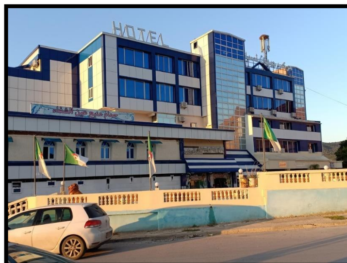
Photo 6.7. complexe hôtelier JIHEN Hammam Debagh Source. Auteur, octobre 2019
