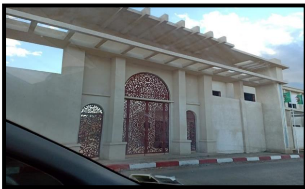
Photo.6.8. Complexe Hammam Belhachani en cours de réalisation. Source. Auteur, Mars 2020
