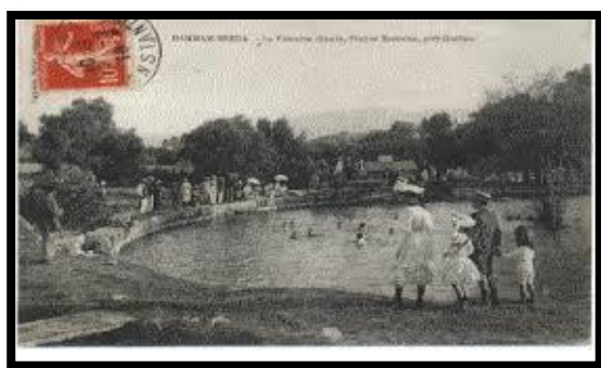
Photo 5.46. Anciennes photos de la piscine. Source : www.benifoughal.com/images/cartes-postales-anciennes/cpa-guelma-page-4/ .
