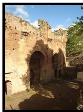
Photo 5.45. Photo récente des thermes. Source : Auteur (2020).
