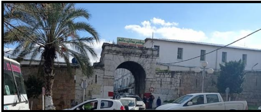
Photo.4.1. L'entrés de l'enceinte construite par les byzantins Source ; Auteur, janvier 2021
