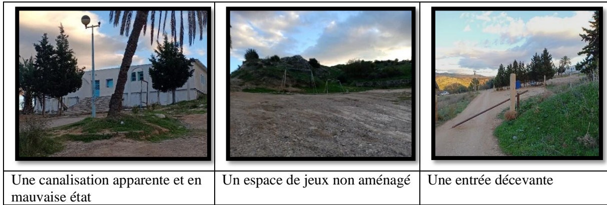
Photos 5.27. État des lieux du Hammam Guerfa.
