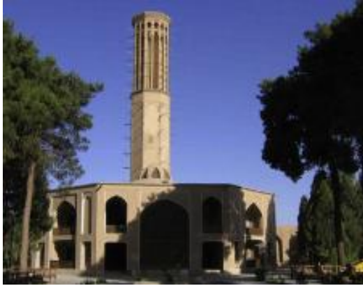
الشكل 7.3. نظام التبريد المباشر بالتبخير باستخدام برج الرياح للباحث "بوشتييري" (المصدر: Poshtiri.2017)
