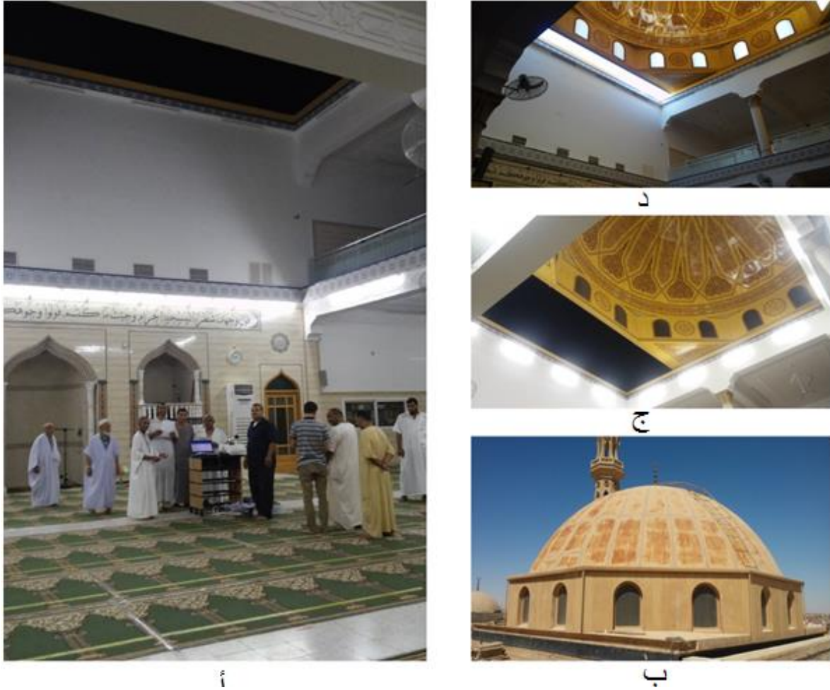
الشكل 15.4. صور القبة المتحركة لمسجد حي تقصبت (أ) الفتحة الكلية للقبة من الداخل (ب) الشكل الخارجي للقبة (ج) فتح القبة أثناء الليل (د) فتح القبة أثناء النهار. (المصدر: الباحث)
