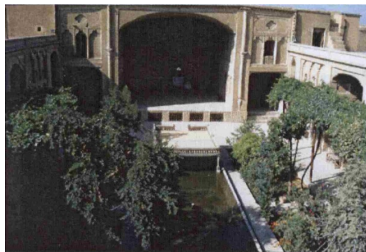
Figure 1. 1 : Bassin d'eau, végétation et allées couvertes de verdure comme moyen de rafraichissement évaporatif passif dans le patio de la maison Lari, Yazd, Iran, (Source : A'zami, 2005)
