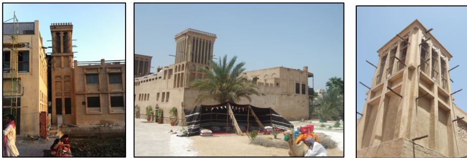
Figure 1. 8: Tour à vent traditionnelle à El Bastakia à Dubaï
