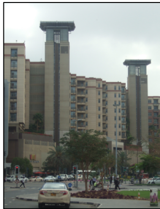
Figure 1.5: Tour à vent (Cage d'escalier et ascenseur), Mall El Ghurair à Dubaï
