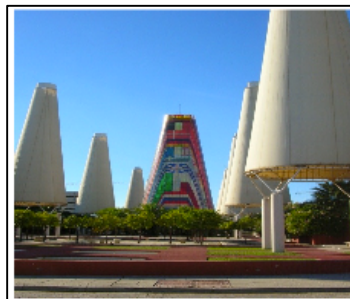
Figure 1. 26: Tours de rafraichissement évaporatif de l'EXPO'92 à Séville (Source: Website, http://wikipedia.org )
